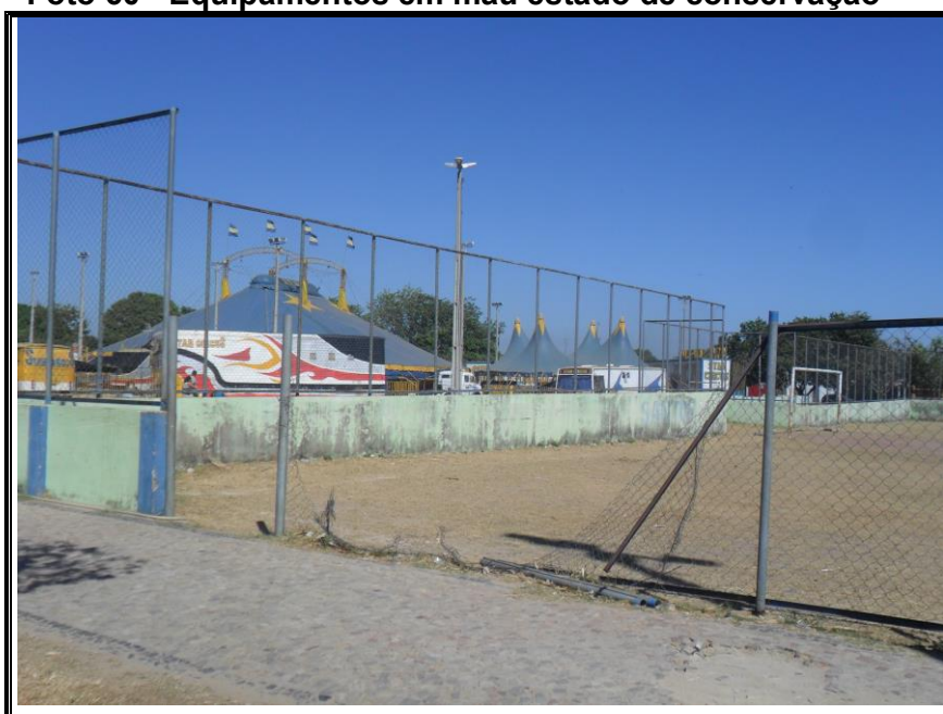
Foto 60 - Equipamentos em mau estado de conservação
