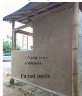
Figura 9 - aplicação do reboco
