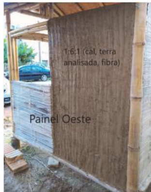
Figura 7 - aplicação do emboço com cal
