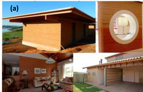
Figura 6 – Taipa de pilão: (a) construção contemporânea, (b) processo de produção de paredes.
