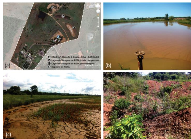
Figura 2: (*) Imagem de satélite da área da Estação de Tratamento de Água (ETA) Meia Ponte (a); Lagoa de secagem em operação (b); Lagoa de secagem cheia (c); Disposição do resíduo em área ao lado da lagoa (d).
