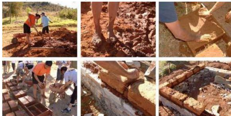
Figura 4 - construção de blocos estruturais em adobe
