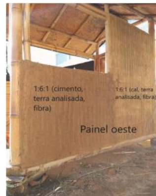
Figura 8 - aplicação do emboço com cimento
