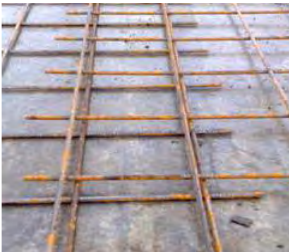
Fig: 18 – Armadura secundária (fio da distribuição)
