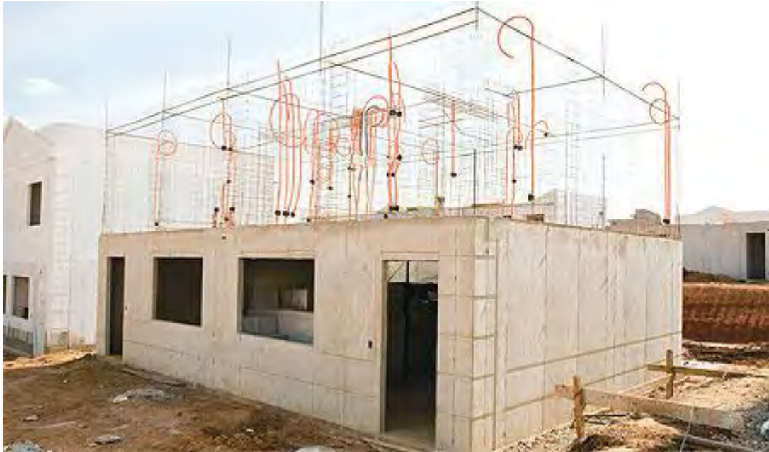
Fig. 02 –Elementos amarrados à armadura antes do fechamento das fôrmas Fonte: Revista Técnica, fevereiro de 2009
