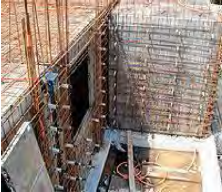
Fig. 07 – Montagem dos painéis internos (fôrmas de alumínio) Fonte: Revista Técnica (edição 147, junho 2009)
