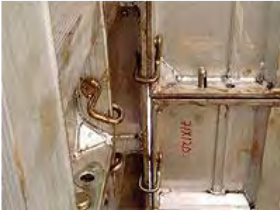
Fig. 11 – Travamento das fôrmas de parede Fonte: Revista Técnica (edição 147, junho 2009)
