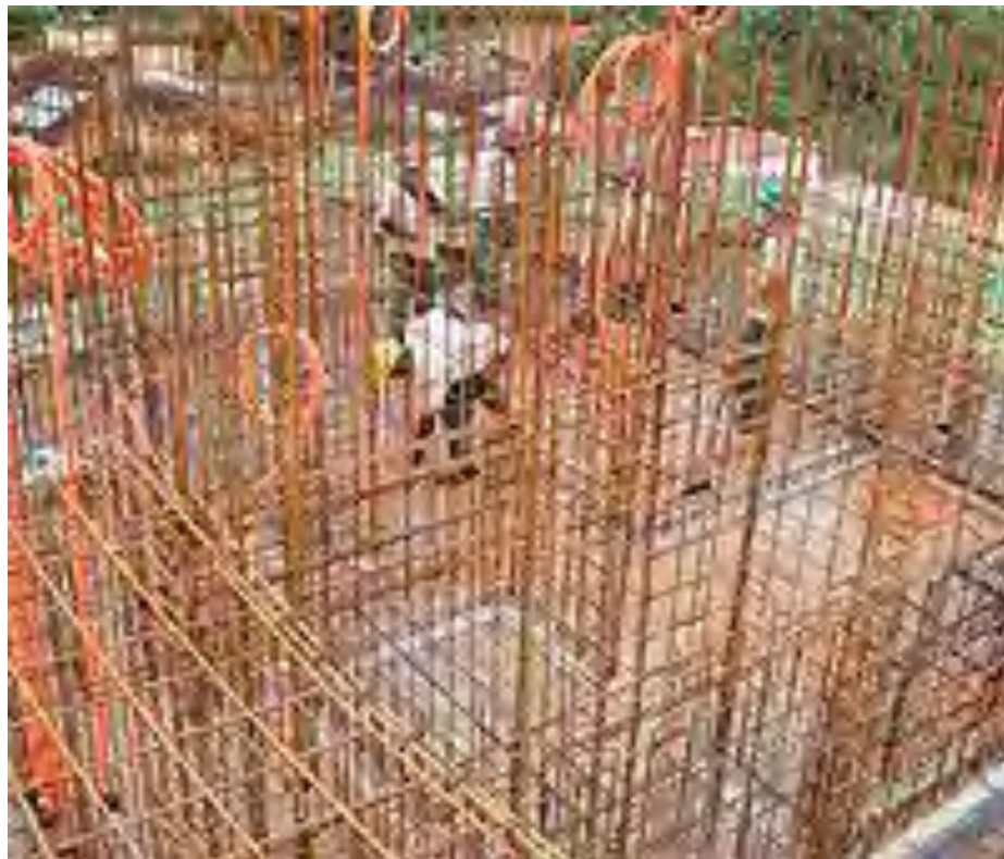
Fig. 06 – Montagem das armaduras e eletrodutos Fonte: Revista Técnica (edição 147, junho 2009)
