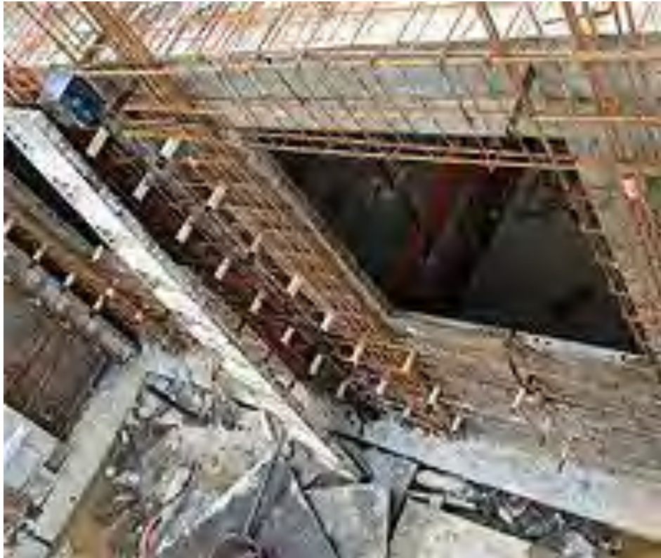
Fig. 09 – Montagem dos painéis externos Fonte: Revista Técnica (edição 147, junho 2009)
