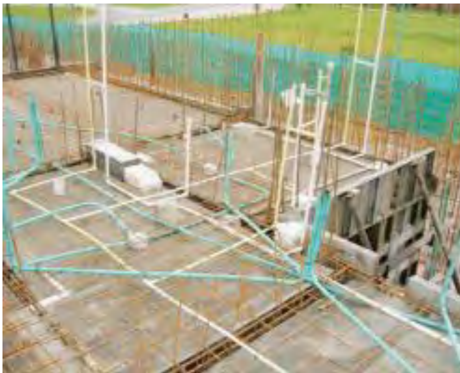
Fig: 22 – Tubulação hidráulica Fonte: Manual Paredes de Concreto 2008/2009
