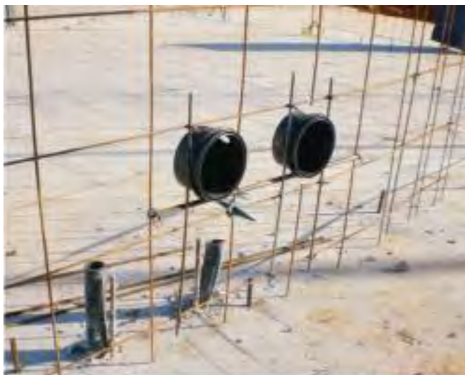
Fig: 20 – Tapa da caixinha de energia fixadas as telas Fonte: Manual Paredes de Concreto 2008/2009
