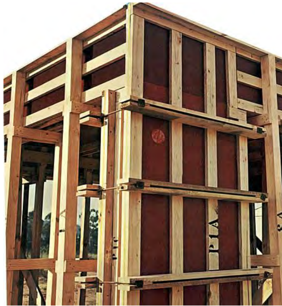
Fig. 04 – Painéis de madeira
