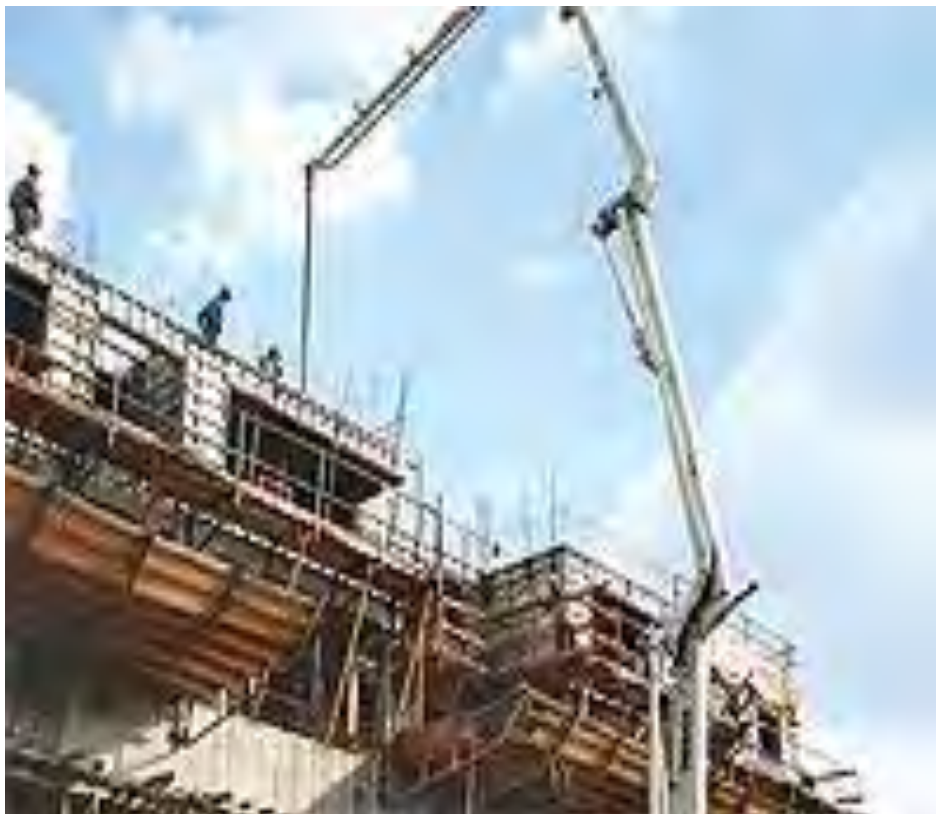
Fig. 25 – Adensamento de concreto com vibrador de mangote Fonte: Revista Técnica (edição 147, junho 2009)
