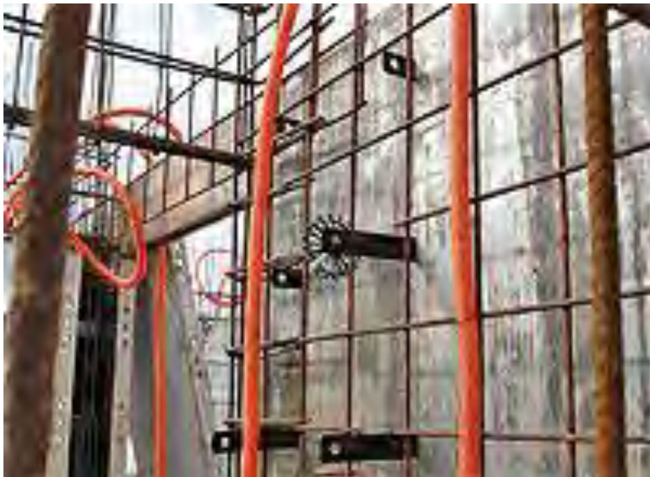
Fig. 10 – Colocação de grampos de fixação entre os painéis Fonte: Revista Técnica (edição 147, junho 2009)
