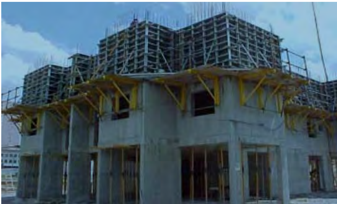
Fig. 01 –Parede de concreto moldada in loco Fonte: UFBA Apostila de Tec. Da Construção Civil – Aula 4B
