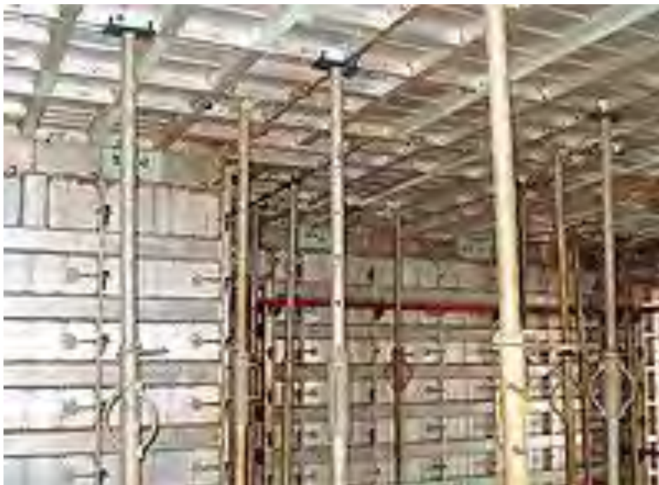
Fig. 12 – Escoramento dos painéis de laje Fonte: Revista Técnica (edição 147, junho 2009)
