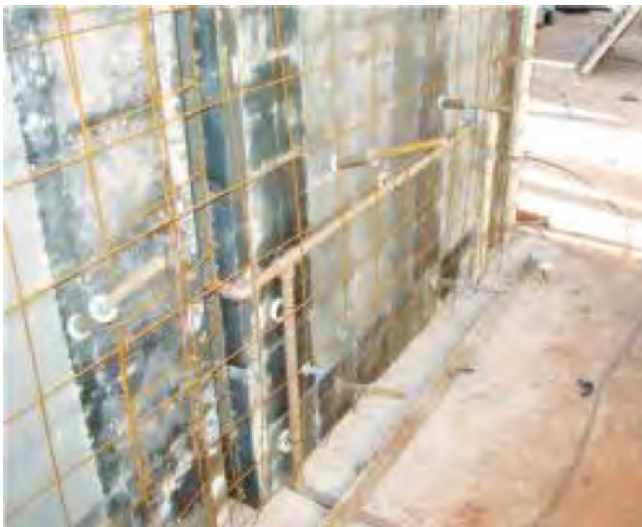
Fig: 21 – Tubulação hidráulica Fonte: Manual Paredes de Concreto 2008/2009
