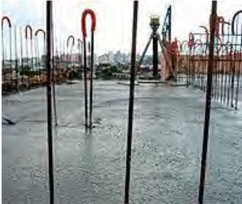
Fig. 05 – Nivelamento de laje Fonte: Revista Técnica (edição 147, junho 2009)
