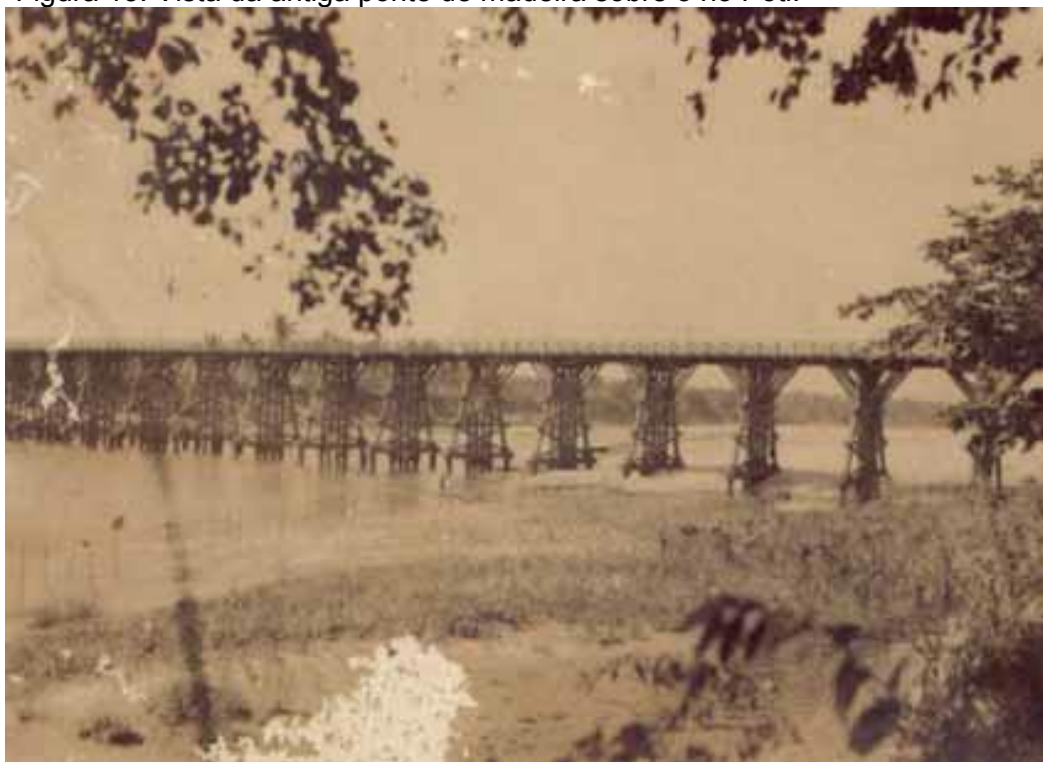
Figura 15: Vista da antiga ponte de madeira sobre o rio Poti.
