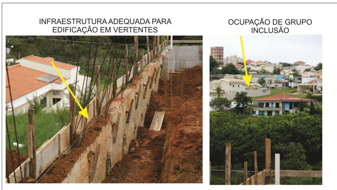
Figura 61. Infraestrutura necessária para ocupação em vertentes, mostrando a construção de muros de arrimos em áreas de alta declividade em áreas de inclusão social intermediária. Data: abr/2012
