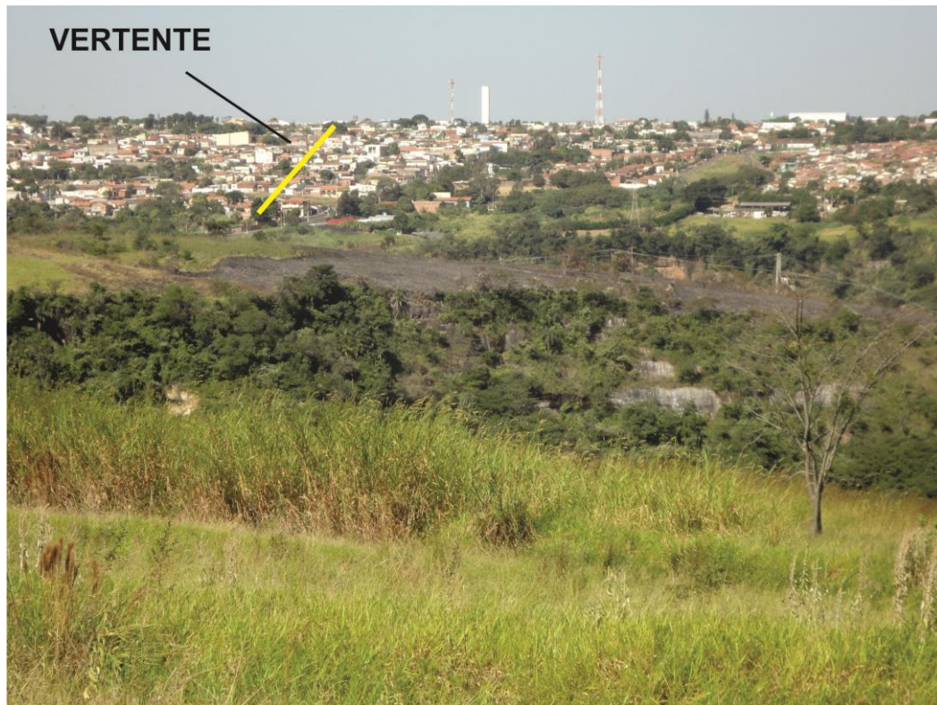
Figura 29. As vertentes apresentam-se quase totalmente ocupadas, onde predomina o uso residencial. As vertentes fazem limites com os topos e as escarpas. Data: ago/2012
