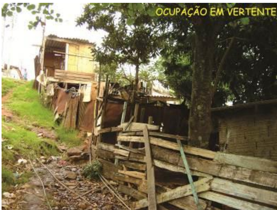
Figura 42. Ocupação irregular em vertentes. Data: fev/2013
