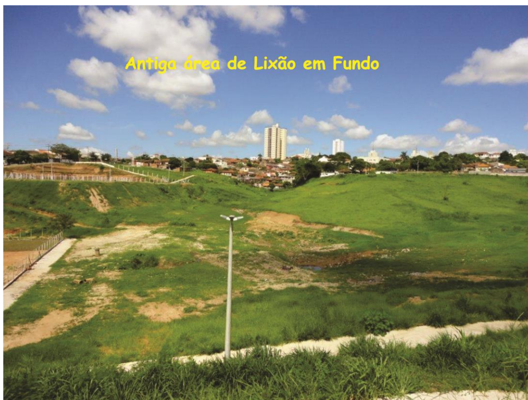
Figura 23. Fundo de vale e vertentes, localizado na Vila Marcondes (zona leste), antiga área de deposição de resíduos sólidos (lixo). Data: out/2011
