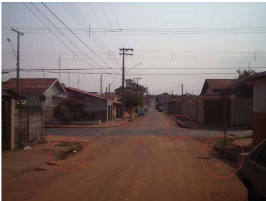
Figura 15 – Localização de bocas de lobo em um cruzamento no setor de nascente (em vermelho). Notar ao fundo a ruptura topográfica e o caimento da vertente. Foto: Alessandra Fagundes, 13/09/2012.
