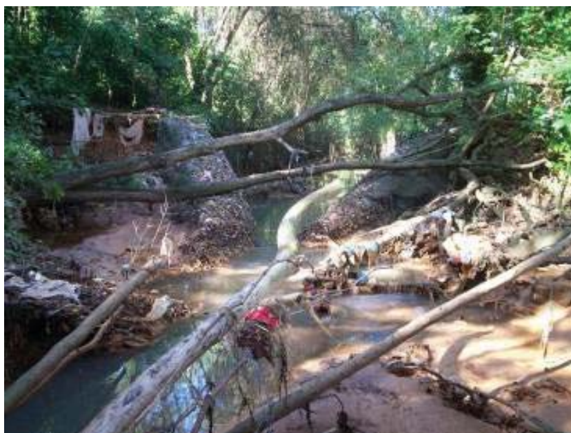
Figura 25 – Trecho localizado após a saída de drenagem. Foto: Alessandra Fagundes, 19/04/2012.
