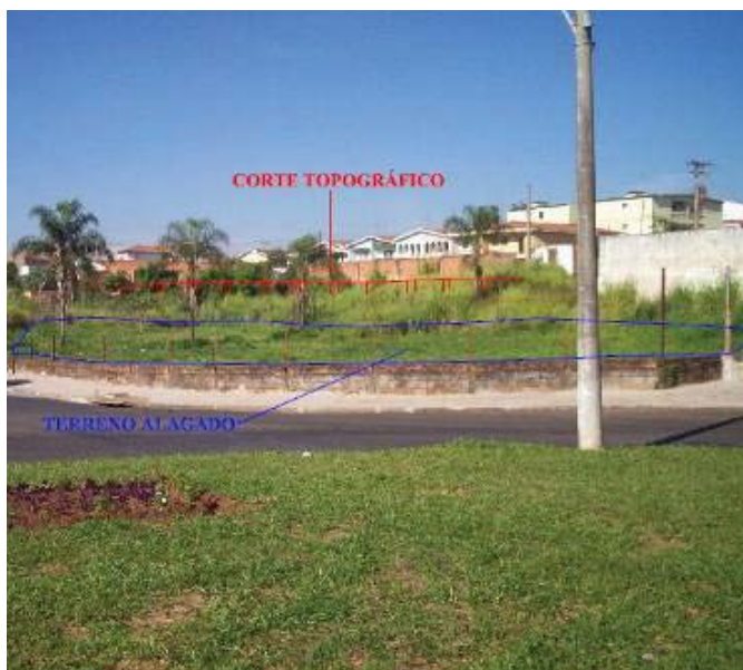
Figura 17 - Local onde se encontra o terreno alagadiço e o corte topográfico realizado por intervenção antrópica. Foto: Alessandra Fagundes, 19/04/2012.
