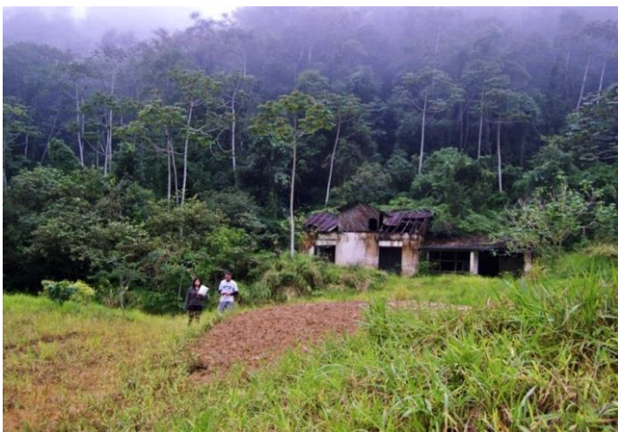
Figura 1 – Aspecto geral das ruínas da mina.
