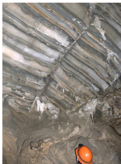
Figura 1 – Falha com rejeito de ordem centimétrica
