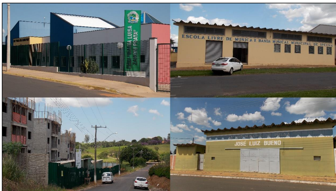
Figura 22: Escola municipal; escola de música; prédios habitacionais em construção, e ginásio de esportes “José Luiz Bueno”
