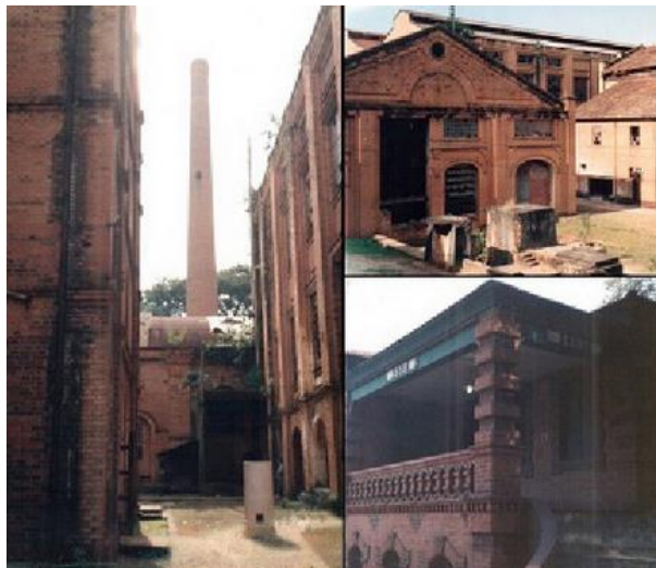
Figura 11 - Engenho central em Piracicaba-SP (1881 - 1974) antes da reforma para abrigar eventos culturais, mostrando o estilo da construção de 1881.
