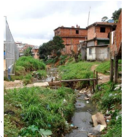
Figura 35: Favela e córrego antes da intervenção.
