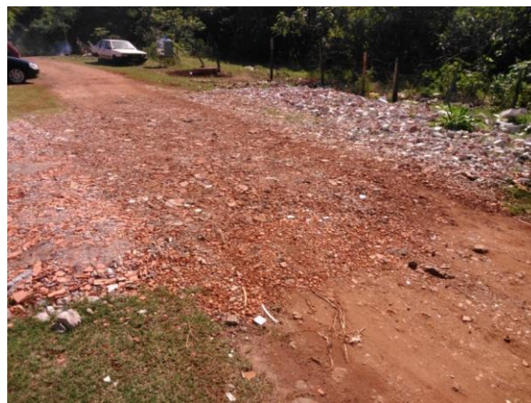
Figura 13: San Rafael. Entulho de demolição na rua Canafístula.
