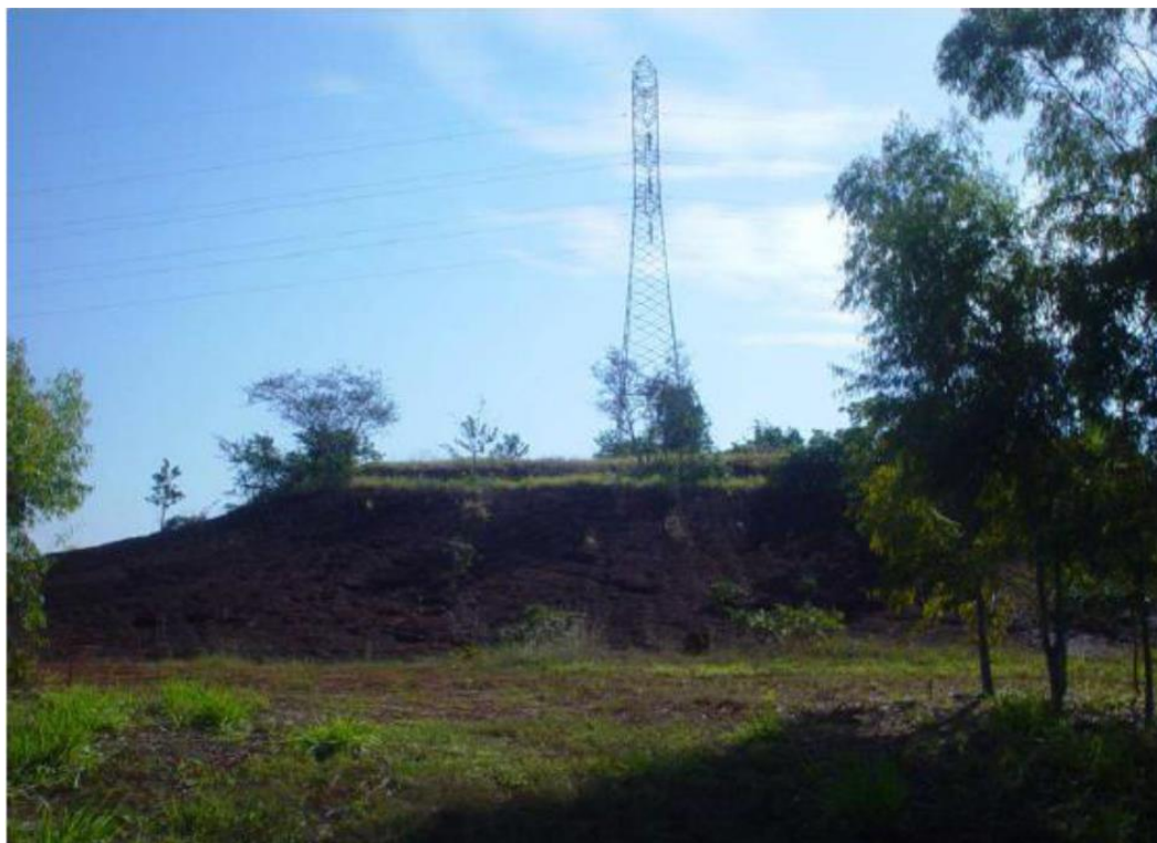
Figura 1: Vista geral da área decapitada mostrando o corte de 8,6 m de espessura.
