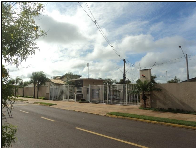
Foto 46 – Vista frontal da fachada do Condomínio Residencial Eco Palace
