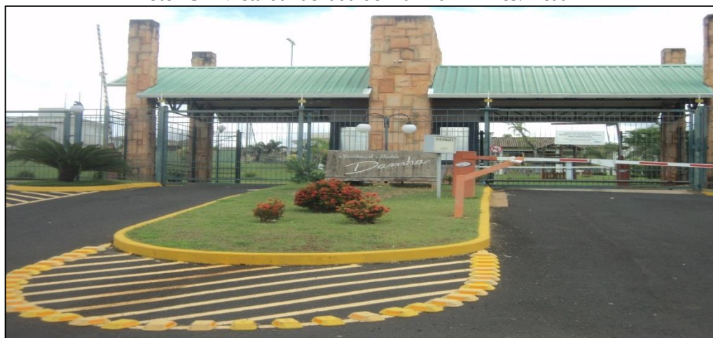
Foto 15 – Vista da fachada do Damha II – Res. Beatriz
