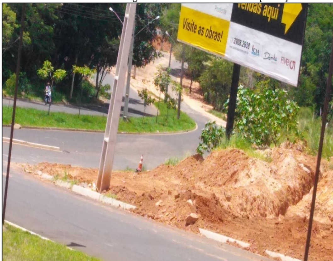
Foto 11 - Trecho da avenida Miguel Damha no momento da implantação do loteamento
