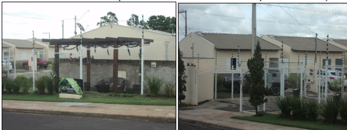
Fotos 53 e 54 – Fachada do empreendimento Residencial Entreverdes e padrão das construções
