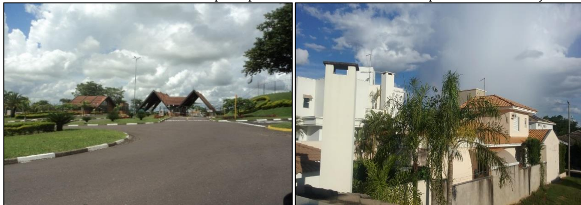
Fotos 10 e 11 – Vista da entrada principal do condomínio Damha II e padrão das construções
