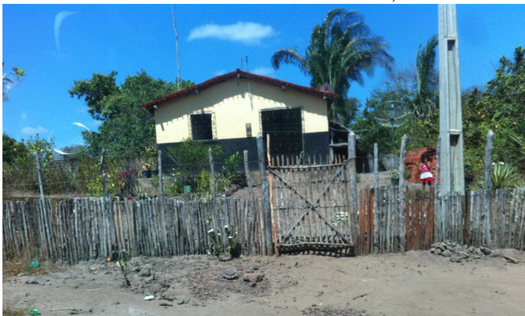
Foto 6 – Casa de morador localizada na localidade Terra Preta, São João do Arraial-PI, 2015.
