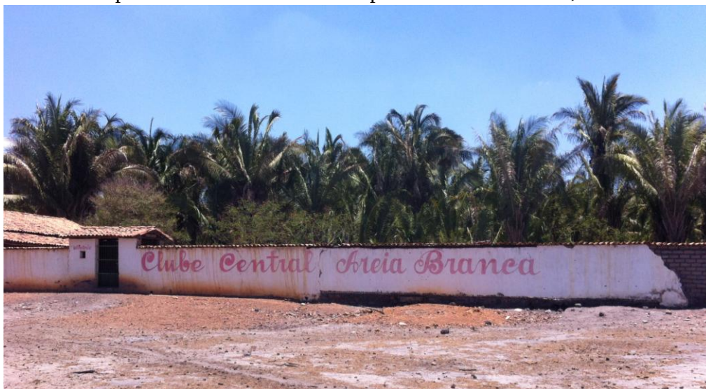
Foto 7 – Empreendimento localizado no povoado Areia Branca, São João do Arraial-PI, 2015.
