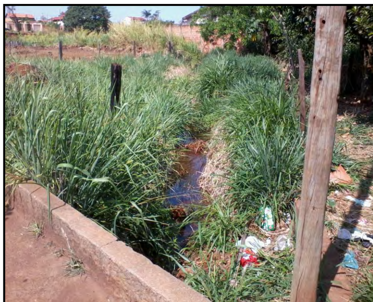
Fig. 38 - Córrego Nova Rincão percorrendo trecho de área urbana, coberto por vegetação. Presença de lixo doméstico a direita da imagem.
