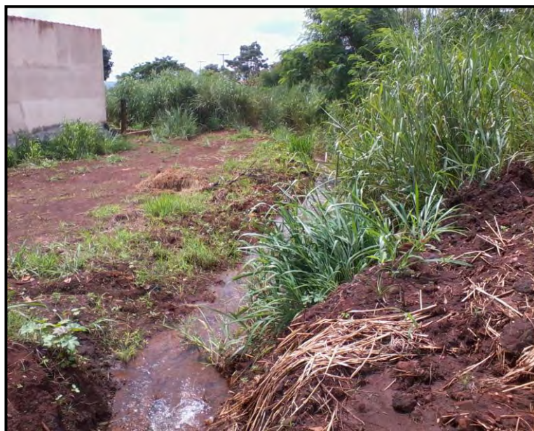
Fig. 22 - Córrego Nova Rincão à montante da área urbana. Margem esquerda construções e margem direita com erosão.
