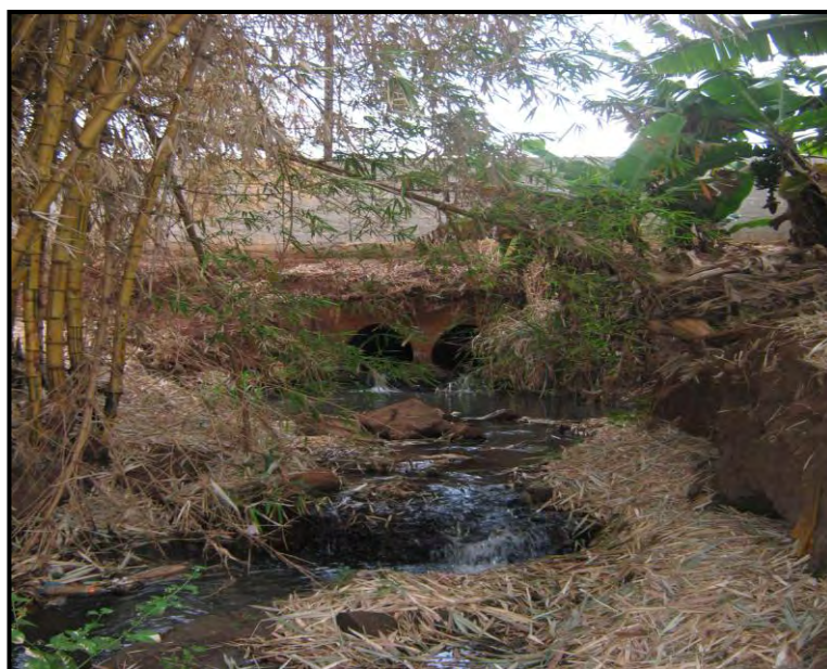
Fig 39. – Córrego Nova Rincão, formado por galeria pluvial e Córrego da Carangola ao fundo da imagem.
