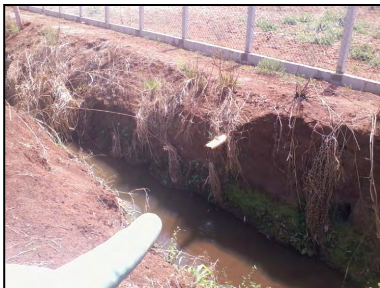
Fig. 61 Tubulação lançando efluentes no córrego
