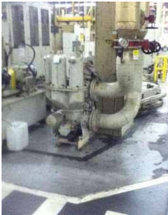
Figura 47 - Foto de um sistema de filtração do tipo Cartucho com mídia de aço inoxidável (GM-SJC)
