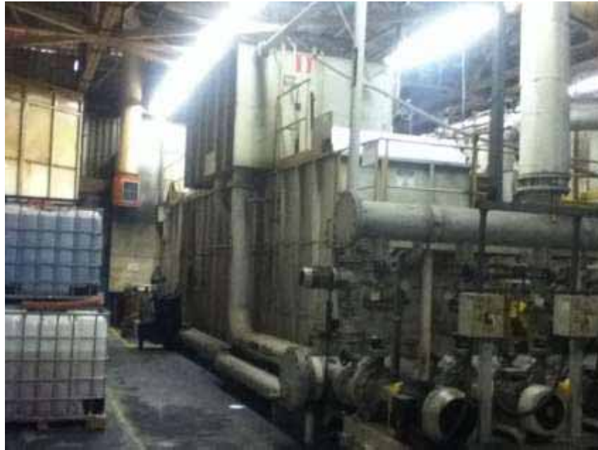
Figura 45 - Sistema de filtragem à vácuo com mídia descartável (GM-SJC)
