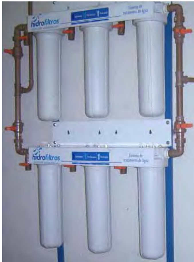
Figura 1. Filtro HF 5000 constituído por elementos filtrantes Big 5 HPC 10" big; Big 50 PF 10" big, Big 5 FF 10" big, Hidrofiltros®, utilizado durante o experimento
