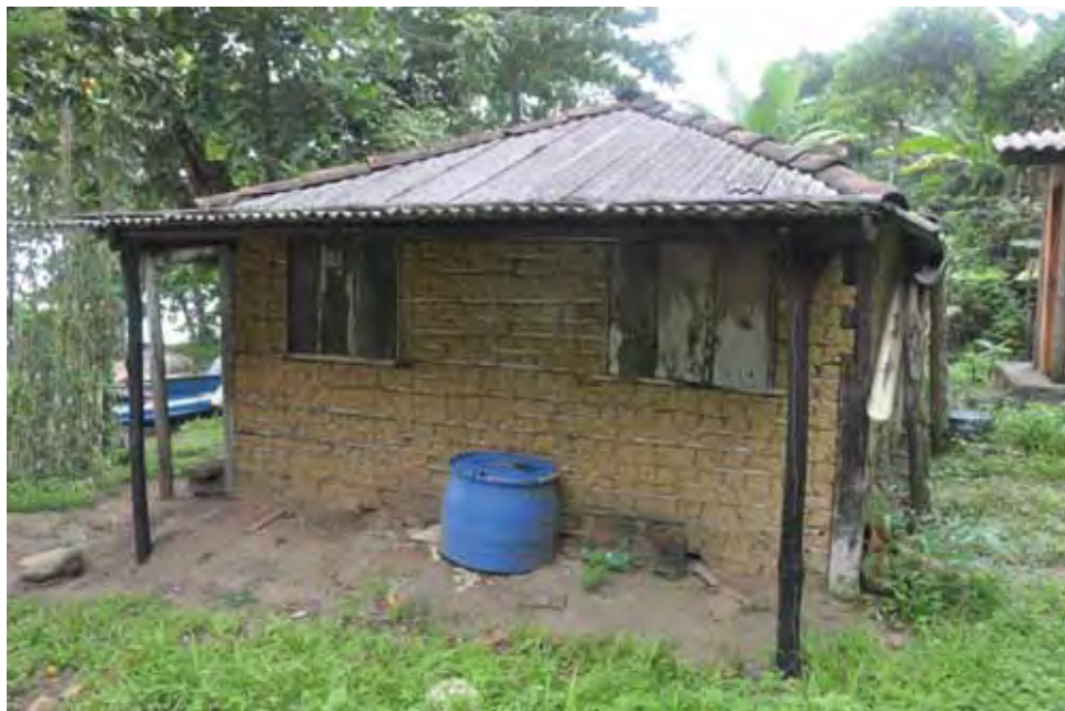
FOTO 21 – Casa de pau a pique na praia Mansa (Fonte: FOTO DO AUTOR, 2011)
