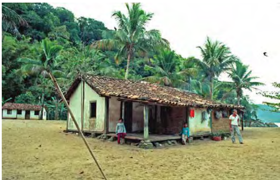
FOTO 59 – Antiga ocupação caiçara no canto norte da praia Vermelha. Vale lembrar que essa foto foi tirada em 1996, antes, portanto, que fossem construídas as casas de veraneio do Sr. Sérgio. (Fonte: NOFFS, 2007, p. 103)
