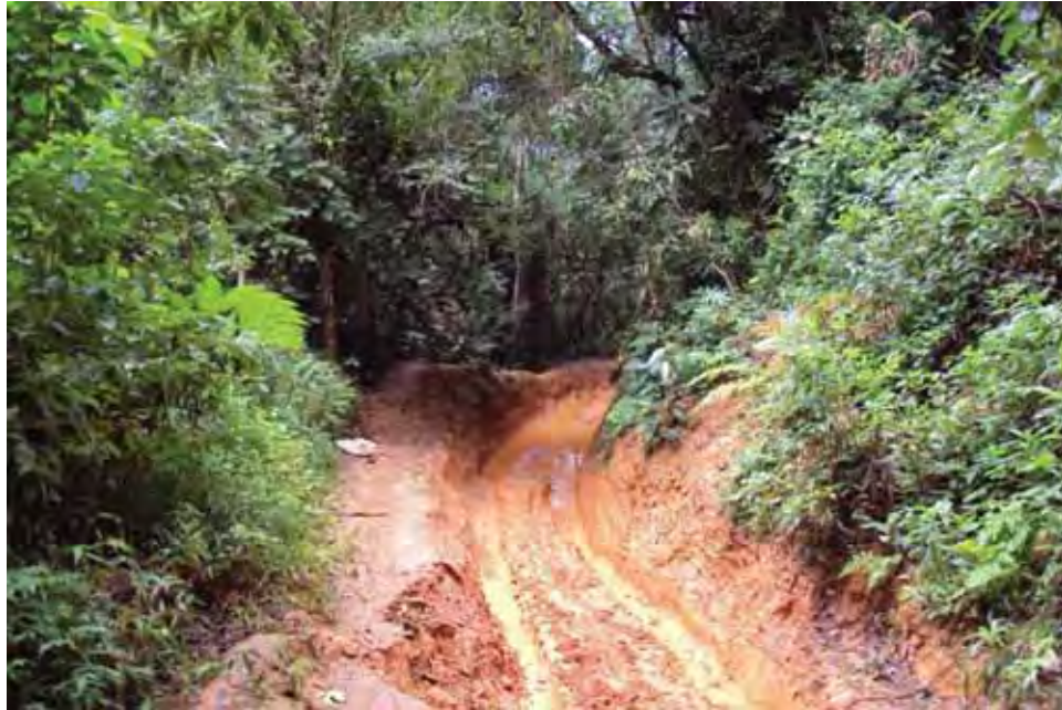
FOTO 17 – Leito carroçável da Perequê-Castelhanos (Fonte: FOTO DO AUTOR, 2010)
