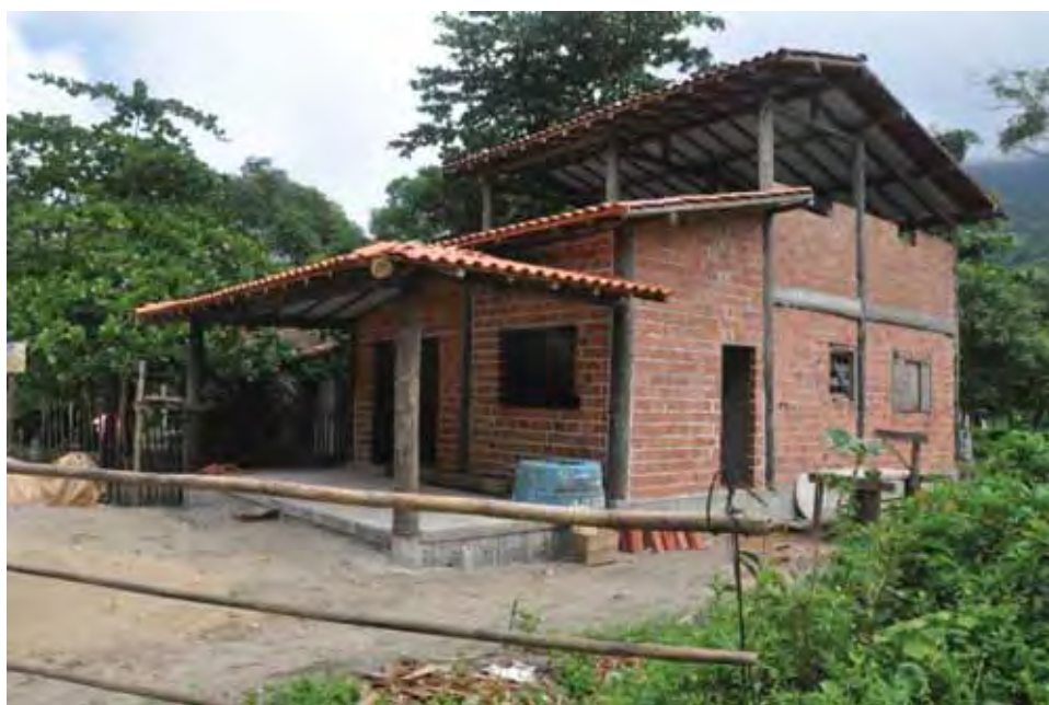
FOTO 58 – Casa recém-aprovada pela prefeitura municipal e em construção no loteamento Vila Reale. Segundo nos relataram os moradores locais, essa casa pertence ao gerente da agência bancária do Banesp de Ilhabela. (Fonte: FOTO DO AUTOR, 2011)
