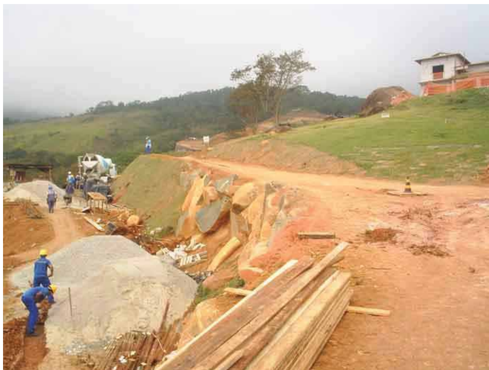
FOTO 37 – Obras de execução do arruamento do YACAMIM (Fonte: < www.infraestrutura.eng.br > Acesso em 14 abr. 2011)
