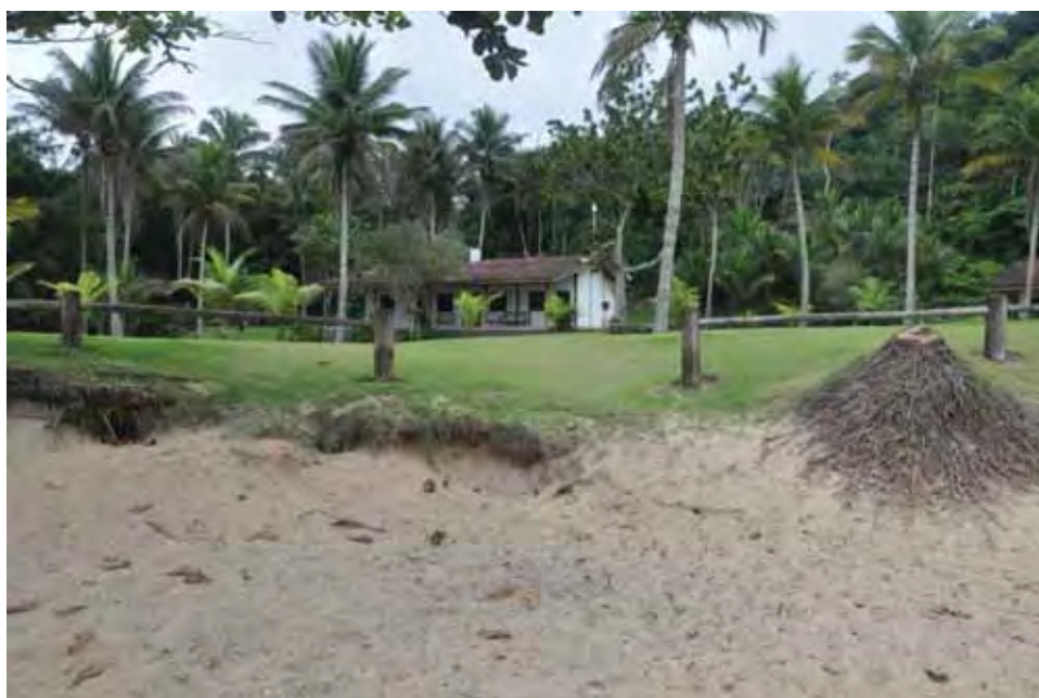
FOTO 61 – Casa de veraneio na praia Vermelha (Fonte: FOTO DO AUTOR, 2011)
