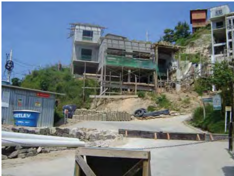
FOTO 39 – Construção de uma residência no complexo hoteleiro-residencial YACAMIM. Note-se que as casas são edificadas com o uso de pilotis, como exigência parcial atribuída pelos órgãos ambientais para o licenciamento do empreendimento. (Fonte: FOTO DO AUTOR, 2009)
