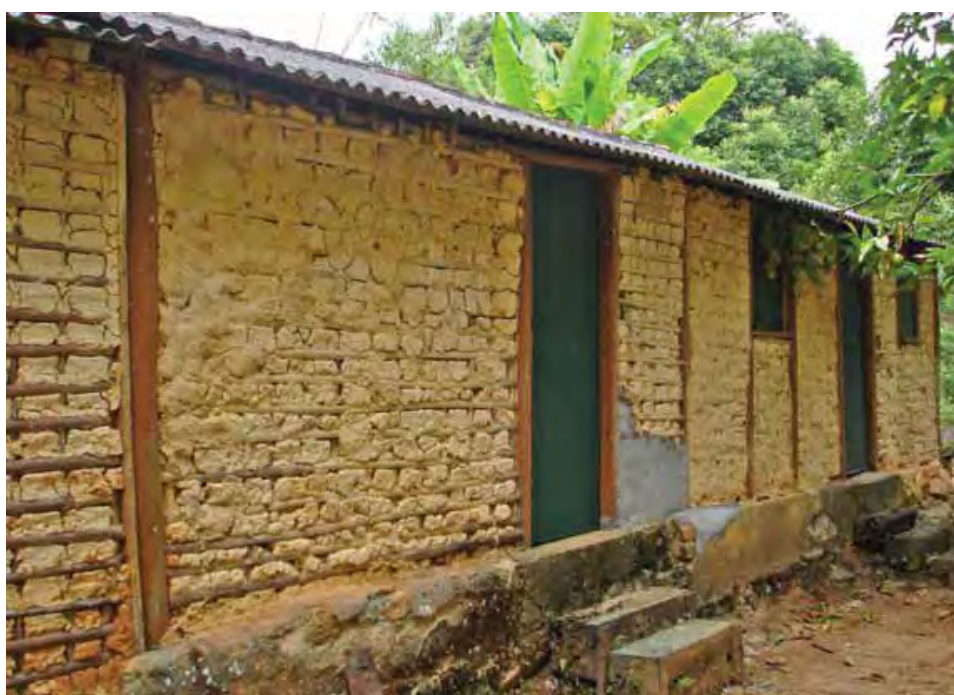
FOTO 67 – Casa de turista feita de pau a pique no Saco do Sombrio (Fonte: NOFFS, 2007, p. 107)
