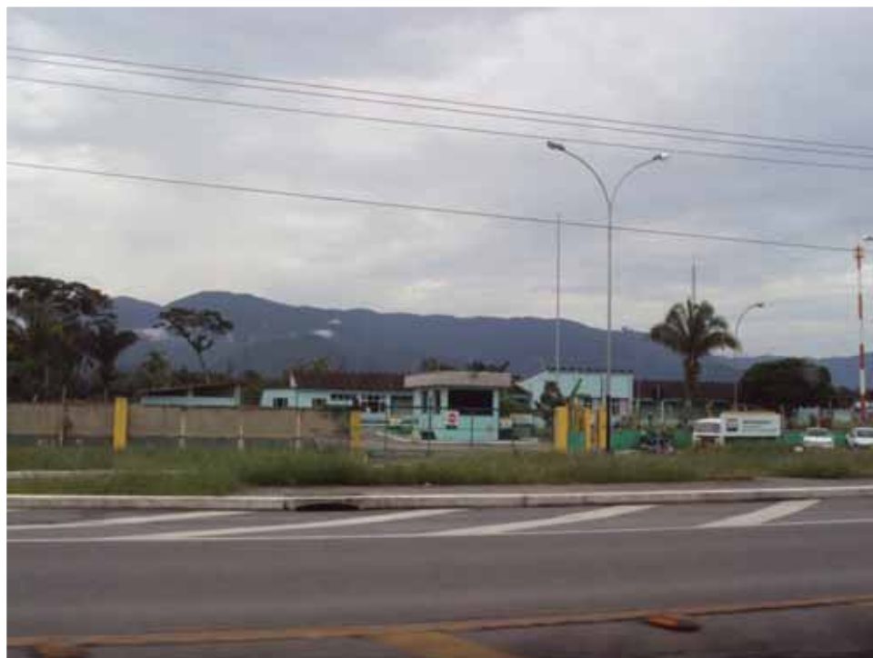
FOTO 04 – Estação Intermediária de Guaratuba (Fonte: FOTO DO AUTOR, 2010)
