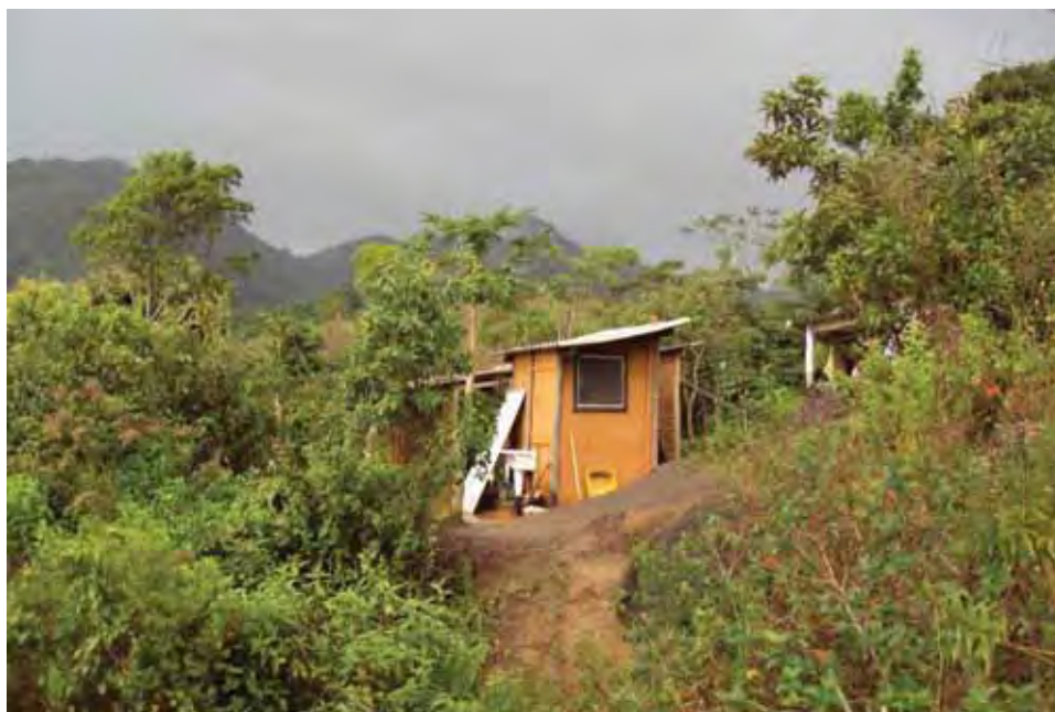
FOTO 51 – Outro banheiro instalado pelo projeto Bela Ilha em residência da praia Mansa. O fato de os banheiros terem sido construídos fora das casas, como forma de preservar a “arquitetura” local, também é objeto de reclamação por parte dos moradores, uma vez que eles continuam tendo de sair de casa para tomar banho ou fazer suas necessidades, o que se torna um fardo em dias de chuva. (Fonte: FOTO DO AUTOR, 2010)
