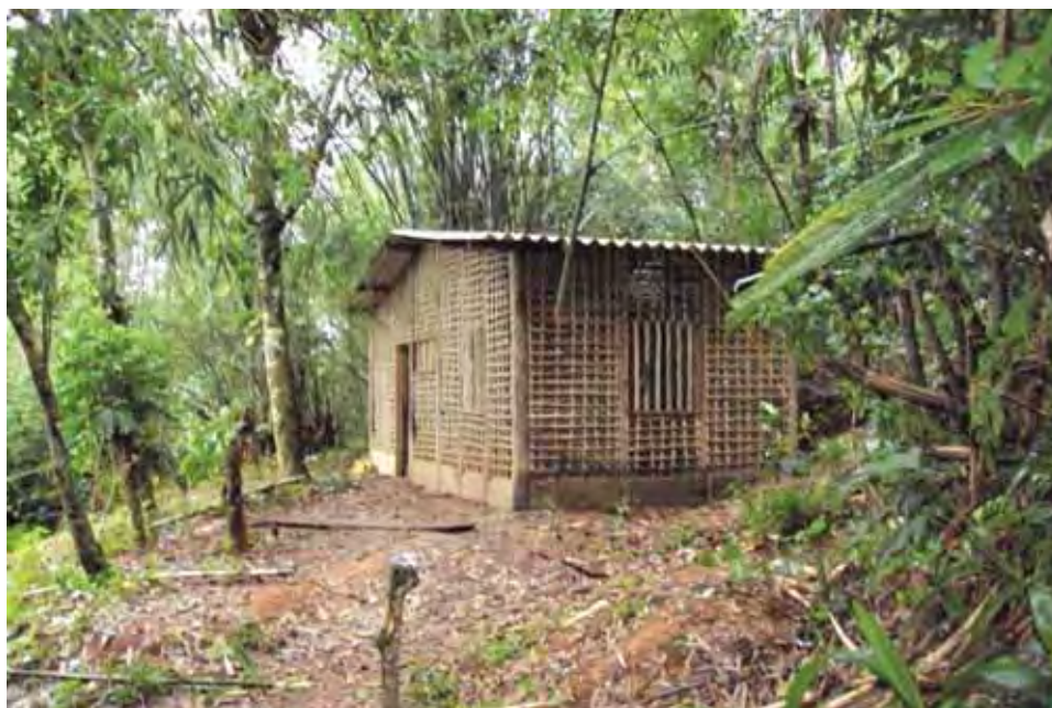
FOTO 53 – Casa de pau a pique em construção no Canto da Lagoa, na praia dos Castelhanos (Fonte: FOTO DO AUTOR, 2010)
