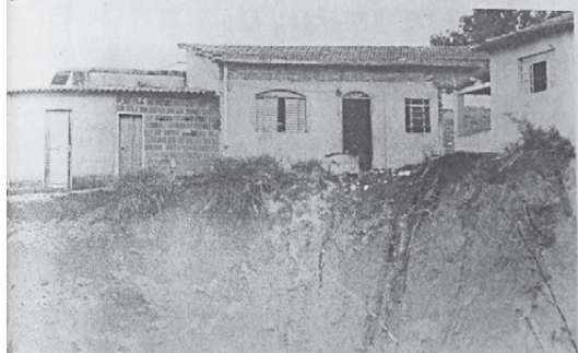
CASAS À BEIRA DA VOÇOROCA: UM PERIGO PARA AS FAMÍLIAS DO ALTO DA BOA VISTA
