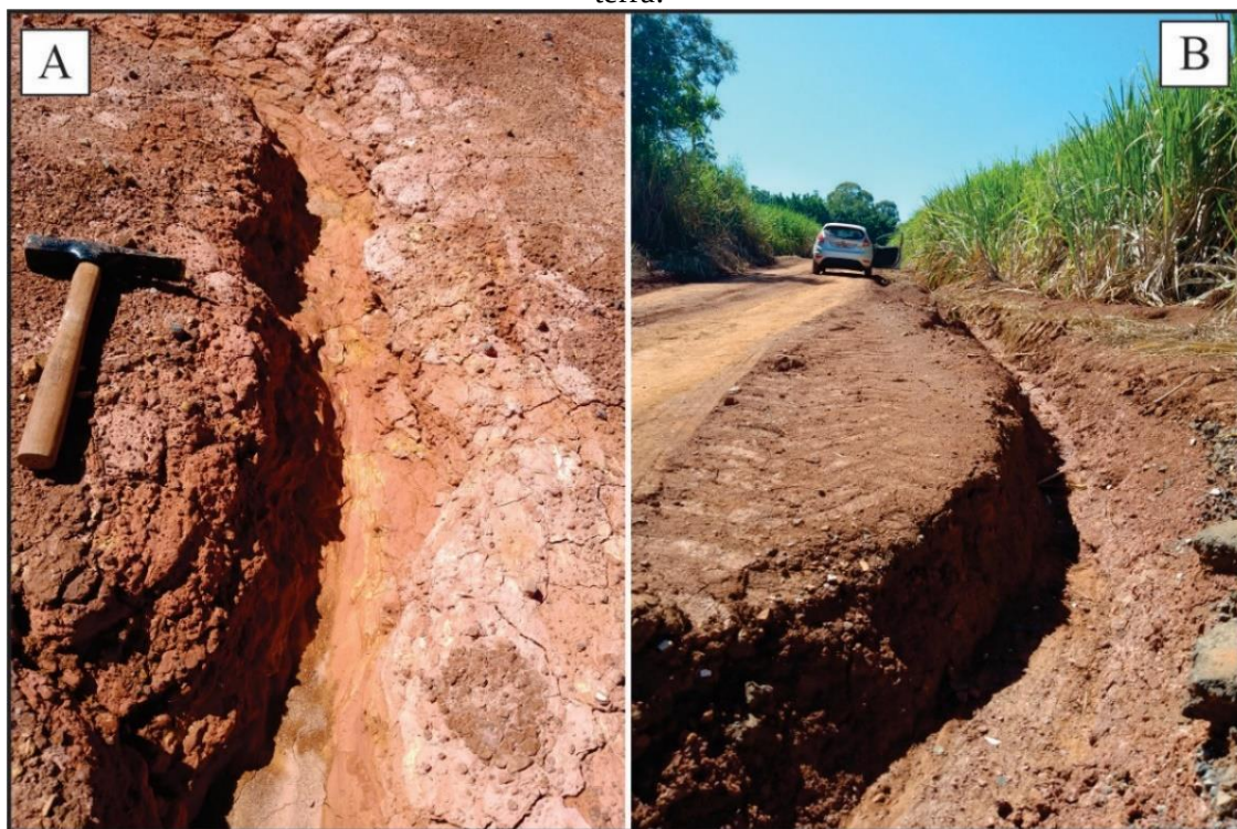
Figura 23 – Detalhe dos problemas associados a erosão na unidade B. Na figura A, é possível observar a formação de sulco no terreno (ponto 20), e na figura B a formação de ravina, na margem de estradas de terra.
