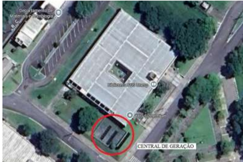
Figura 16 - Localização da central de geração no campus da FEG-UNESP.
