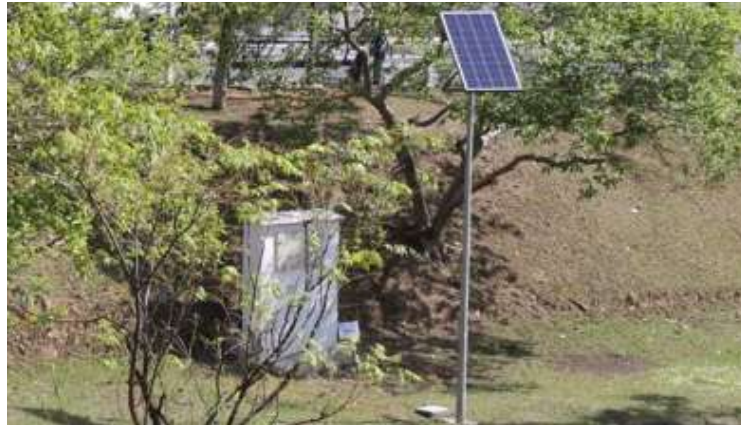
Figura 9 - Instalações do Projeto Ponto Iluminado.
