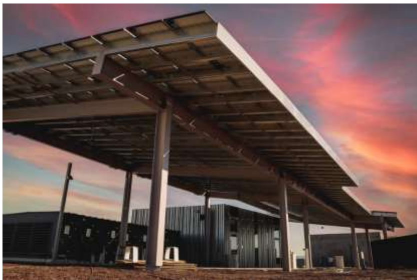
Figura 6 - Sistema de painéis solares instalados no telhado do ENR2.
