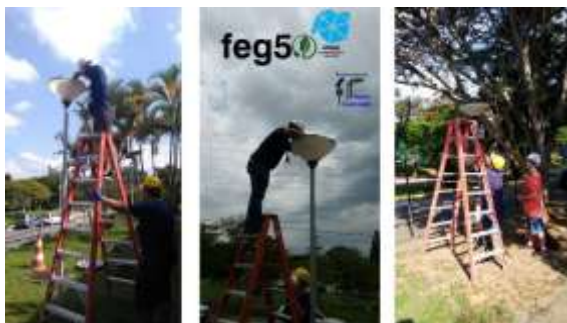
Figura 12 – Ação de modernização dos postes ornamentais em áreas externas.
