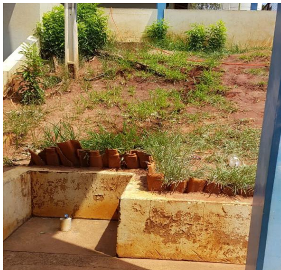
Figura 6: Fotografia da área não impermeabilizada da escola, em frente a algumas salas de aula.
