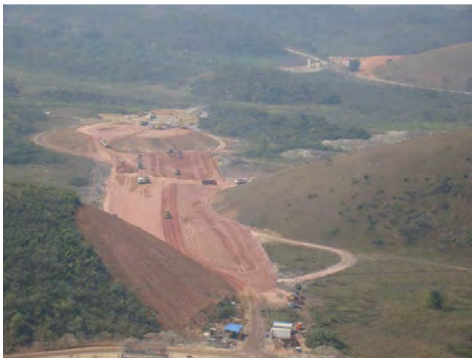
Figura 21 – Obras civis observadas em campo.
