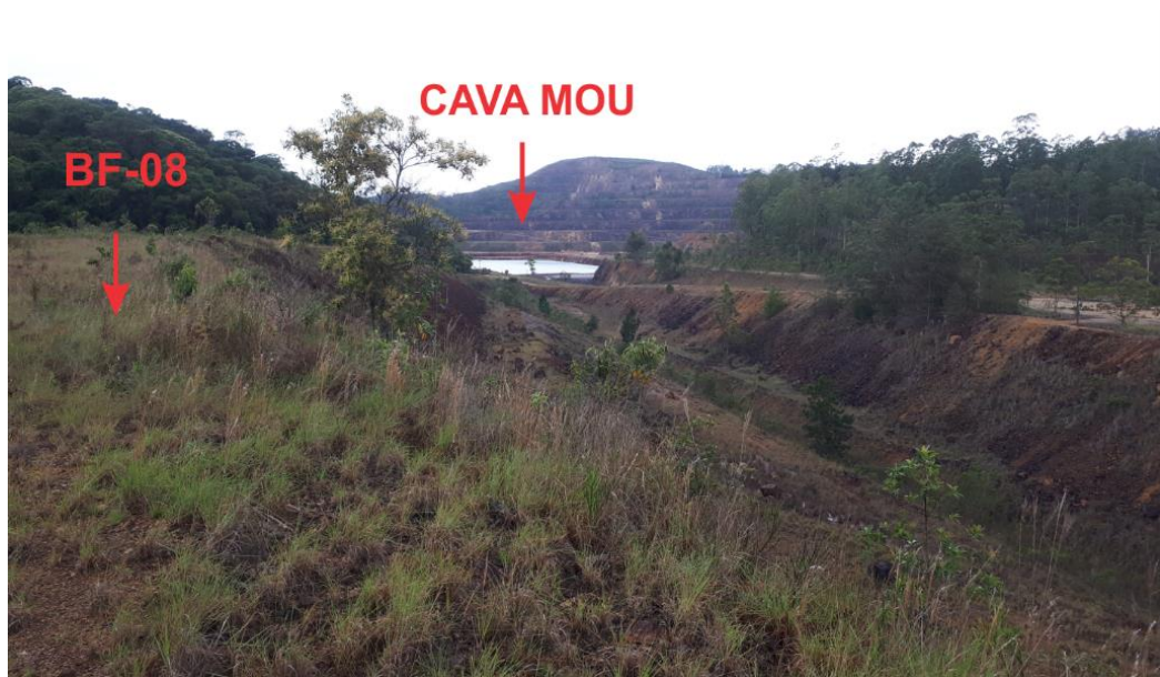
Figura 8 – Vista da porção leste do BF-08 e cava da MOU
