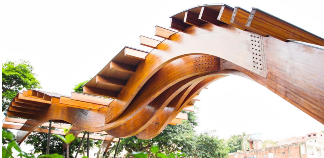
Figura 2 – Estrutura em MLC – Portaria Cerejeiras.
