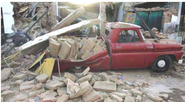
(a) Estragos provocados pelo tremor na cidade de Ica, Peru.
