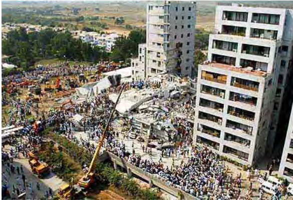
(a) Escombros de prédio de dez andares, destruído por terremoto em Islamabad, no Paquistão.
