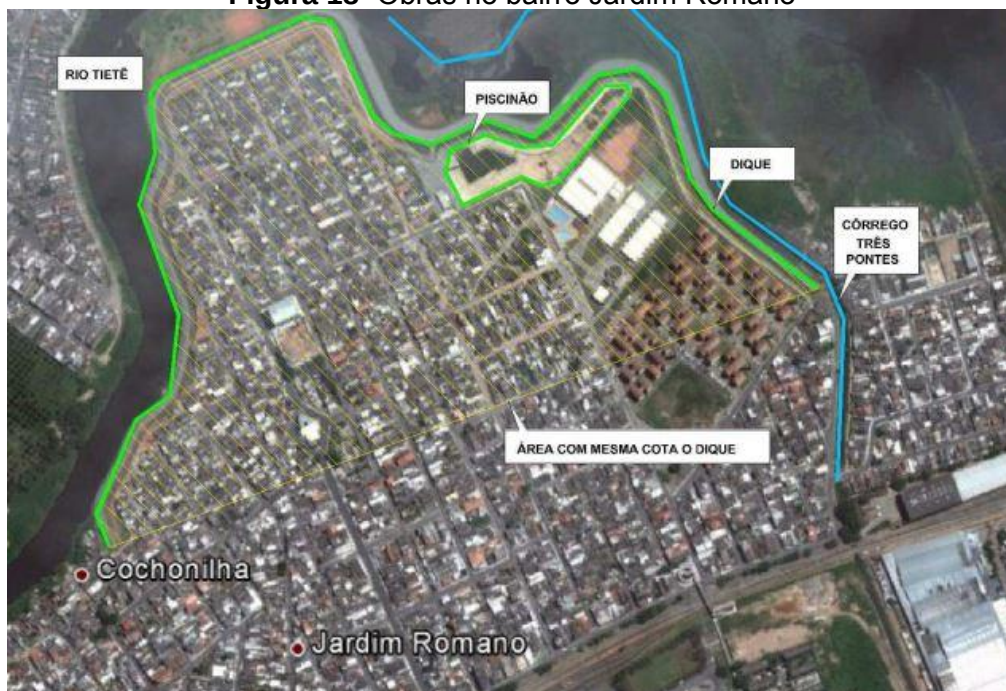
Figura 18- Obras no bairro Jardim Romano
