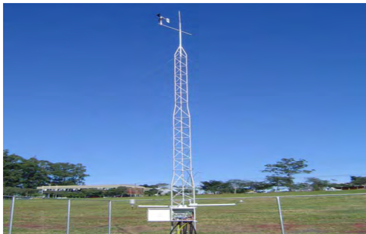
Figura 20 – Torre para instalação de equipamentos meteorológicos
