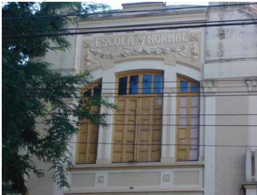
Figura 5 – Fachada atual (ainda conservada) da Antiga Escola Normal de Piracicaba , atualmente Escola Estadual Sud Mennucci
