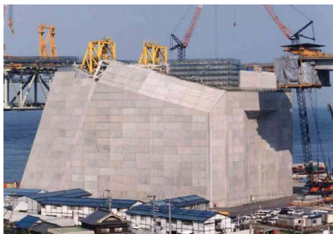
Figura 2 – Momento da concretagem da ancoragem 4A da ponte Akashi-Kaikyo, Kobe, Japão
