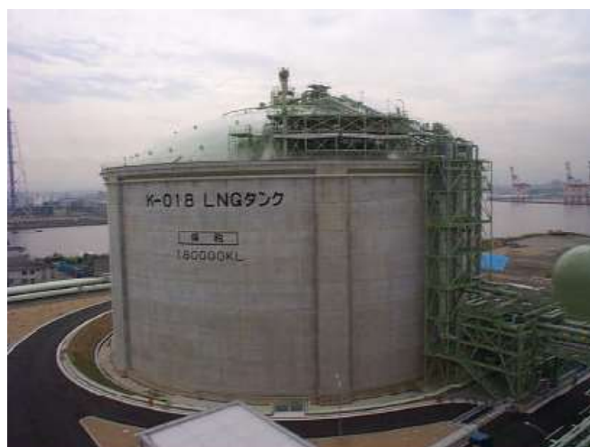
Figura 3 – Tanque de GNL, da Osaka Gas Company, construído com CAA, Osaka, Japão.
