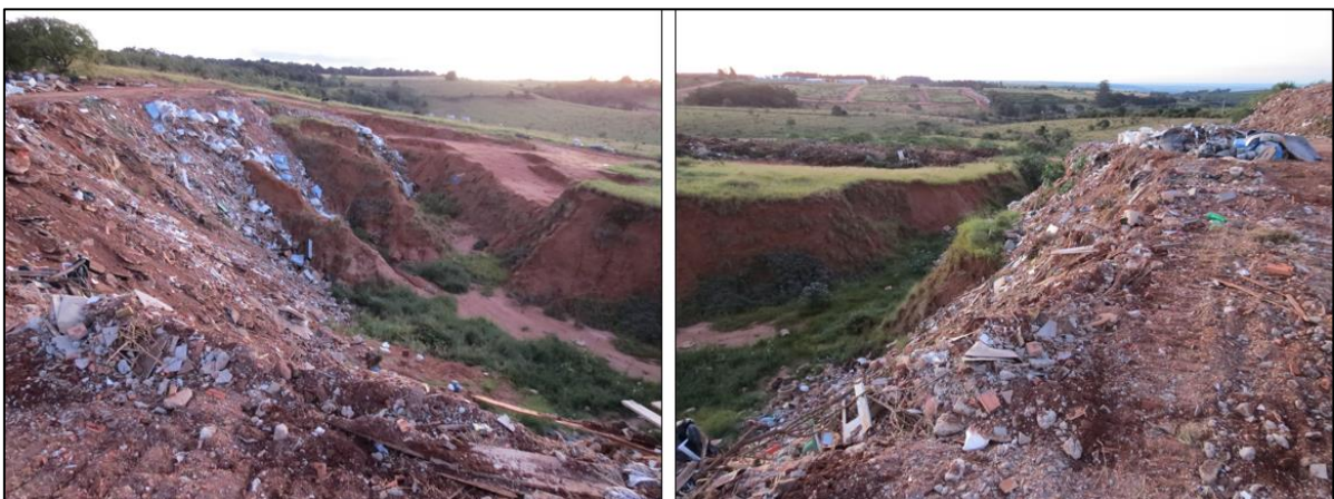
Figura 42: Uso de resíduos urbanos (entulho) para o aterramento de uma voçoroca próxima ao Distrito Industrial II (Botucatu – SP)
