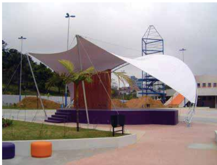
Figura 43. Exemplo da cobertura tensionada adotada no teatro de arena. Fonte: www.tensoestruturas.com Acesso: setembro de 2011.
