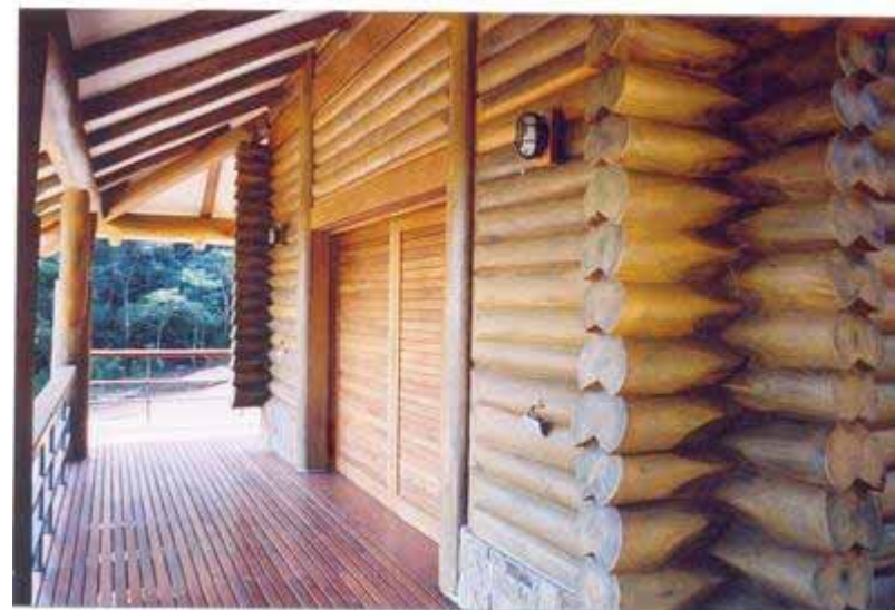
Figura 40. Exemplo do uso de toras de eucalipto como elemento estrutural e construtivo. Fonte: www.estruturasdemadeira.blogspot.com Acesso em: outubro de 2011.
