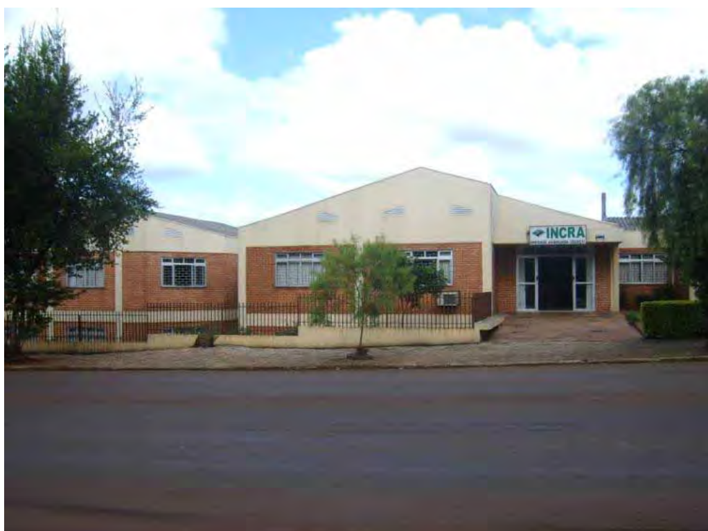
Figura 58: Local onde se instalou o antigo Getsop, atual Incra. Fonte: Registro do autor (janeiro, 2011).
