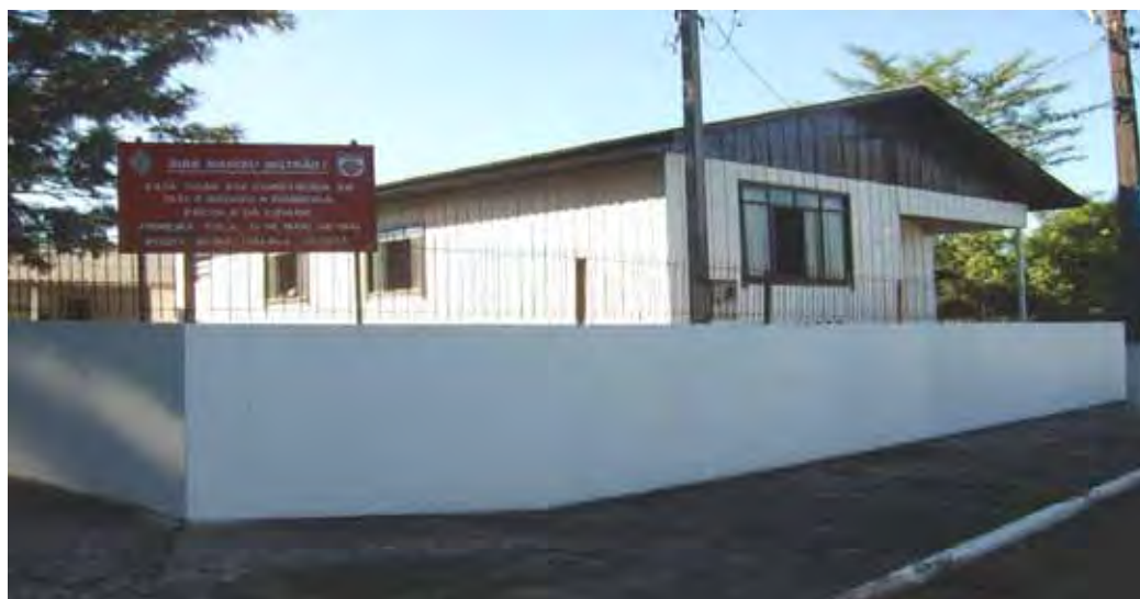
Figura 41: Primeira escola construída pela Congo, perto de suas instalações. 95 Fonte: Registro do autor (abril de 2010).
