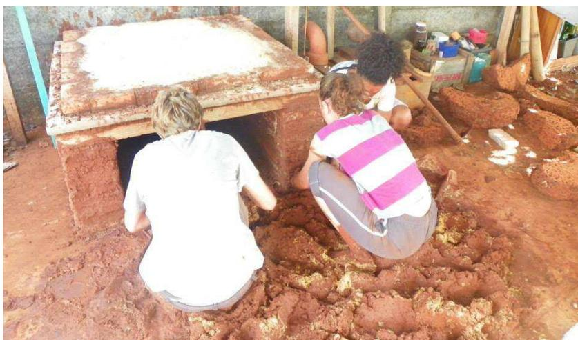
*Figura 27: construção do forno de cupinzeiro no SAF*
