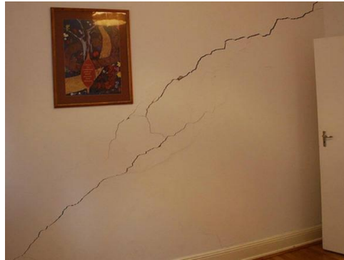
Figura 4 - Trinca em um prédio. 3
