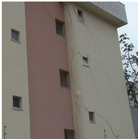
Figura 4 - Trinca em um prédio. 3
