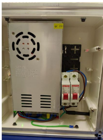
Figura 44 – Montagem dos componentes, painel de potência.
