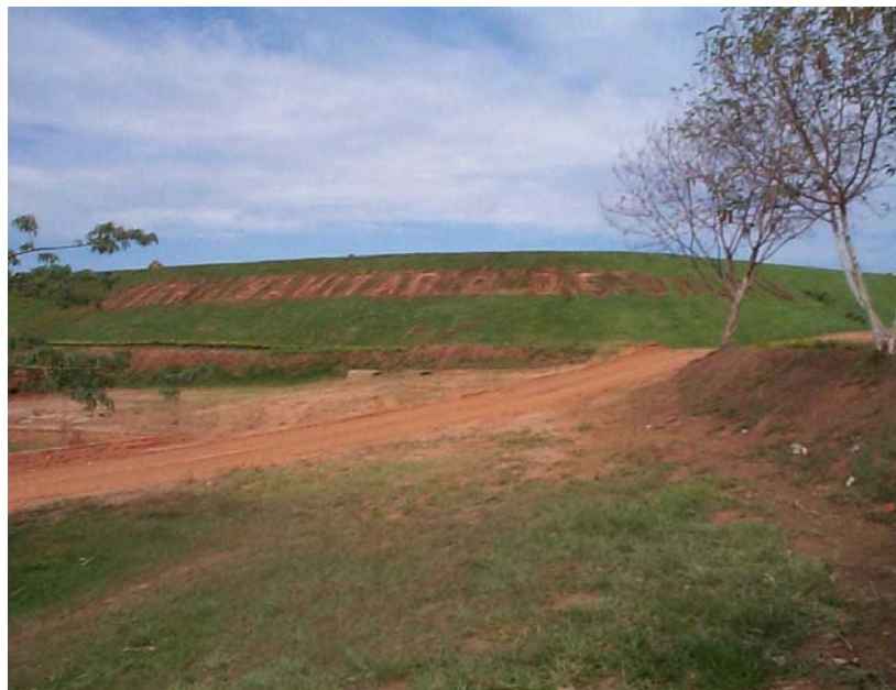
Foto 4.2: Vista do aterro de Bauru (Julho/2003) em que se observa, em primeiro plano, a 1ª Camada de disposição de resíduos.
