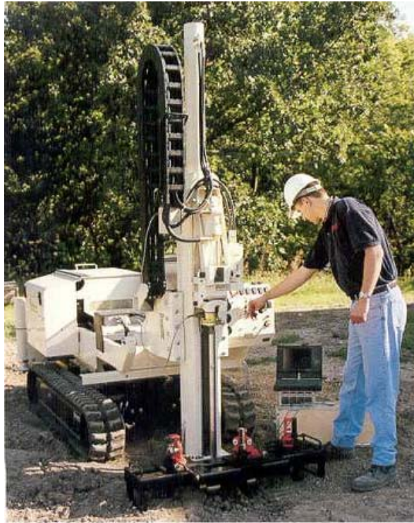
Foto 3.7: Penetração de amostrador de água direct-push sendo executado no campo (www.geoprobe.com)
