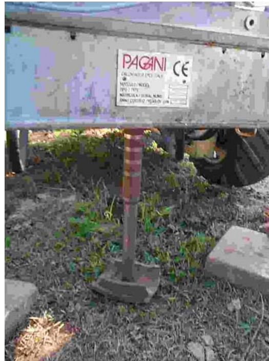
Foto 4.13: Detalhe da sondagem com piezocone de resistividade sendo realizada na área do aterro de Bauru.
