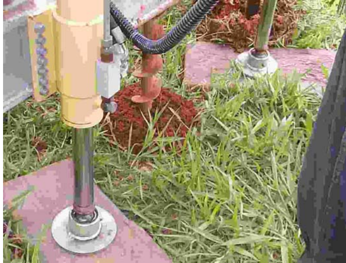
Foto 4.8: Perfuração do poço temporário de monitoramento no aterro de Bauru
