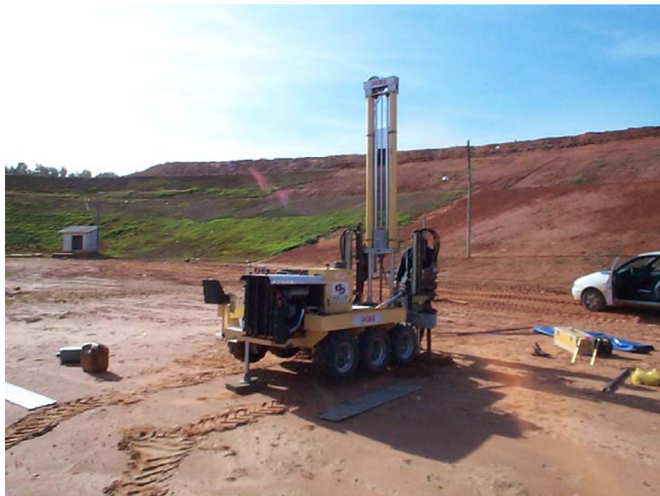
Foto 4.11: Penetrômetro multi-função utilizado nos ensaios com piezocone durante ensaio no aterro de Bauru.
