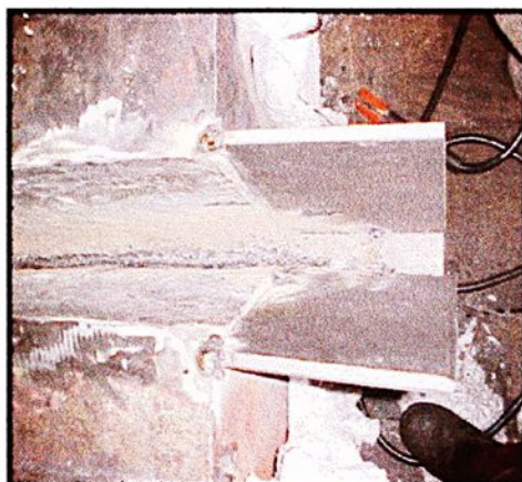
Figura 1.5 – Preparação da abertura da trinca para soldagem.
