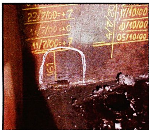
Figura 1.4 – Remoção da trinca utilizando eletrodo de grafite.
