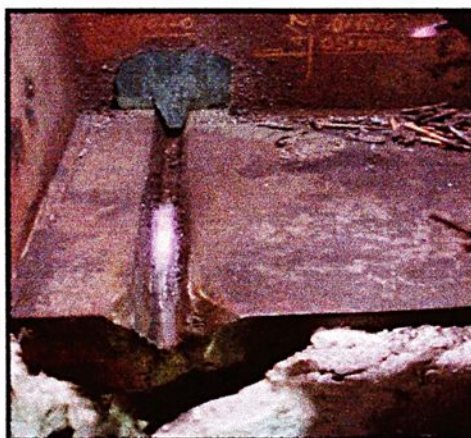
Figura 1.4 – Remoção da trinca utilizando eletrodo de grafite.
