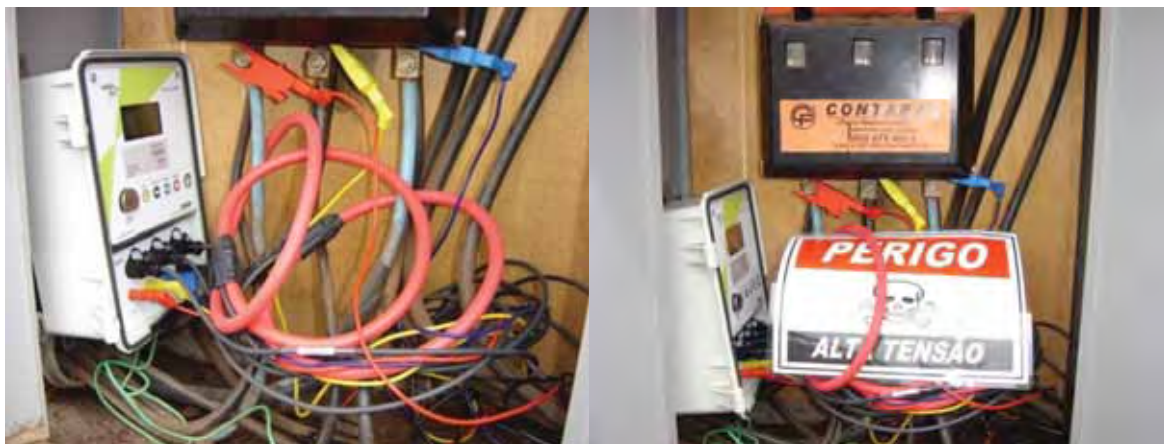
Figura 42. Analisador Portátil Saga 4500 ligado em rede trifásica junto à entrada de energia na Serraria B.
