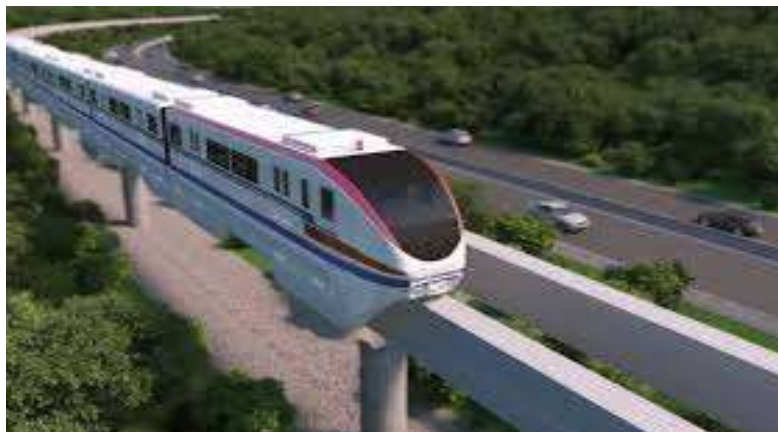
Figura 2 - Monotrilho lateral implantado na faixa de domínio da rodovia
