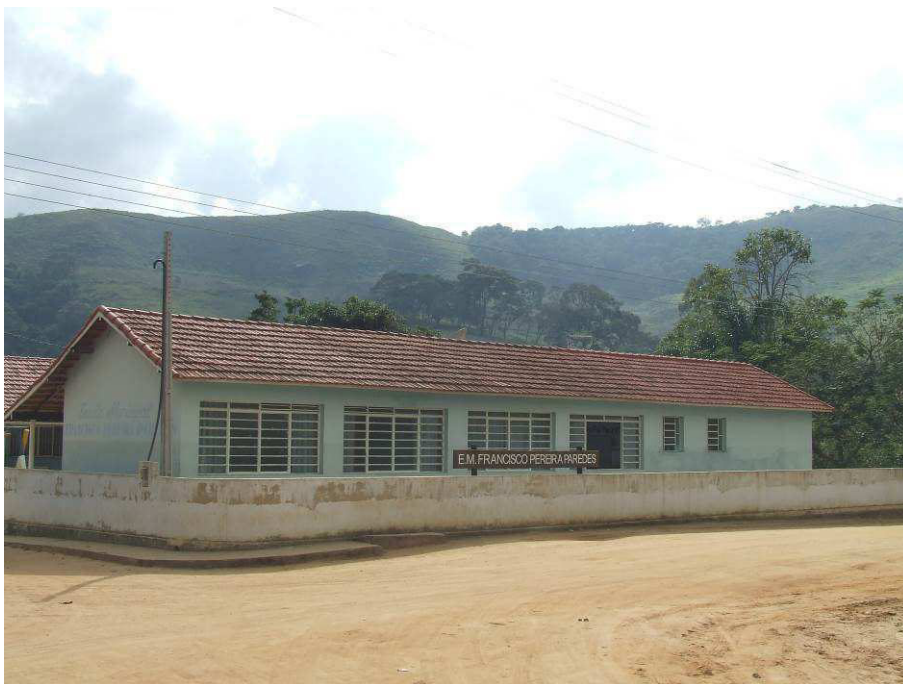
Foto 03 – Fachada atual da Escola Municipal Francisco Pereira Paredes, onde funcionou o radioposto
