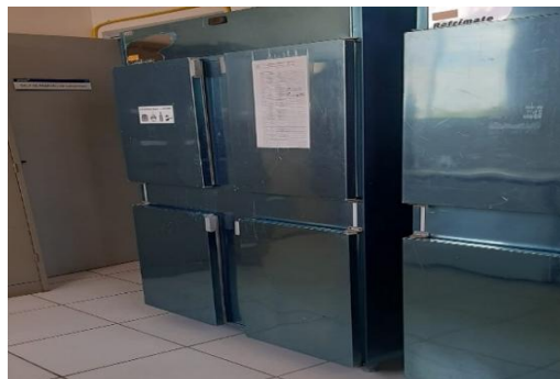
Figura 5. Câmaras de refrigeração na sala de armazenamento de amostras, para amostras que necessitam ser mantidas sob refrigeração. Fonte: arquivo pessoal, 2025.
