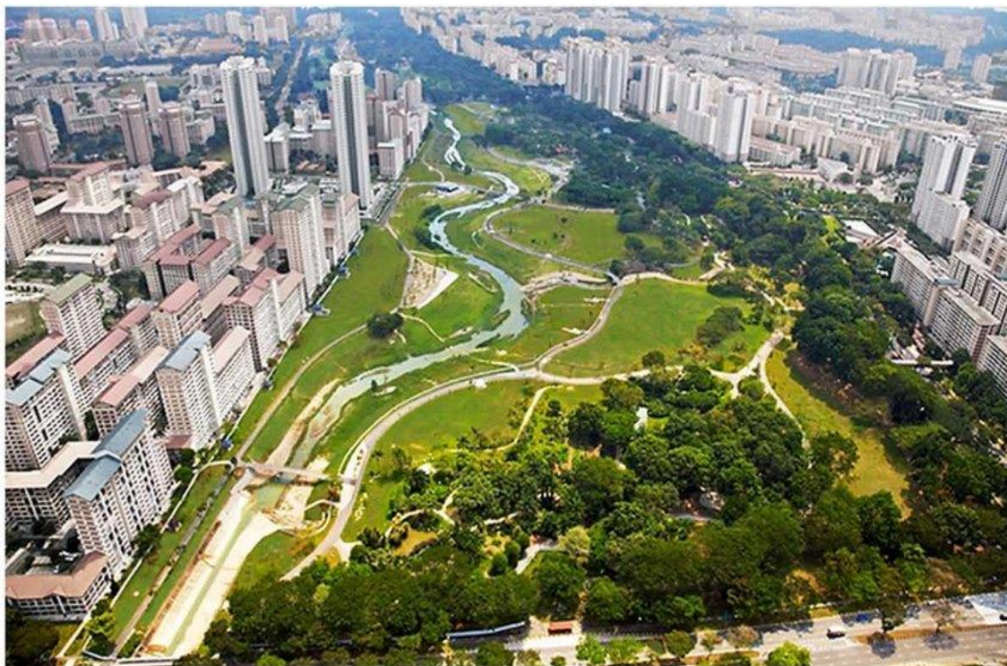
Figura 2.4. Exemplo de Drenagem Urbana aplicada: Singapura, 2019). Disponível em: http://infraroi.com.br/wp-content/uploads/2019/03/Aerial-view-of-Kallang-River-Bishan-Ang-Mo-Kio-Park-Singapore-Source-Wikimedia.jpg , acesso em julho/2020.
