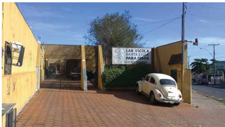
Figura 12 – Fachada do Lar Escola Santa Luzia para Cegos. (da autora)
