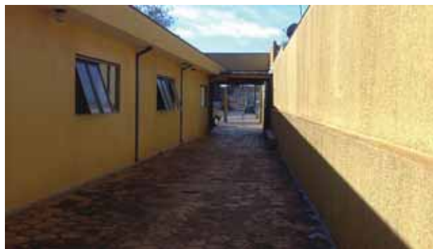
Figura 15 - Vista dos fundos do corredor externo de acesso. (da autora)
