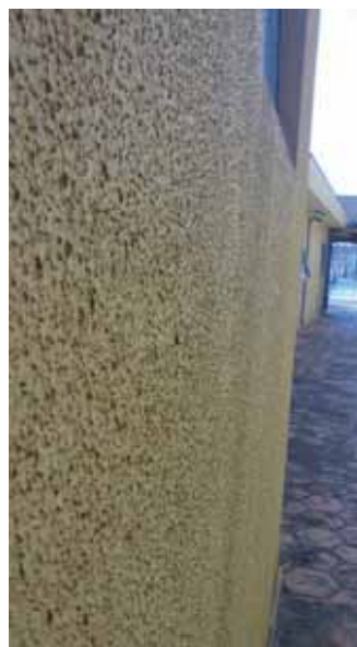
Figura 20 - Detalhe da textura das paredes externas. (da autora)
