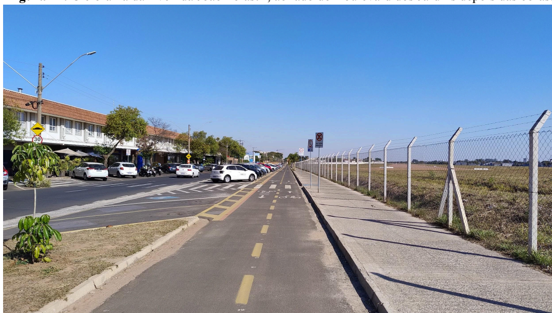
Figura 44: Ciclofaixa da Avenida João Polastri, ao lado do Boulevard dos Jardins depois das obras:
