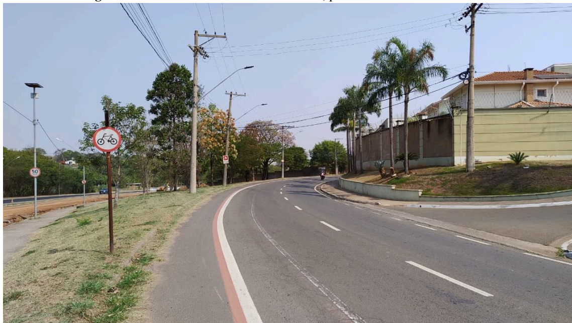
Figura 46: Ciclofaixa da Estrada dos Costas, próximo à rotatória da Viviane.
