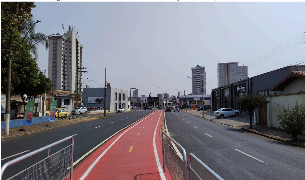
Figura 22: Avenida Visconde de Rio Claro após a construção da ciclovia.
