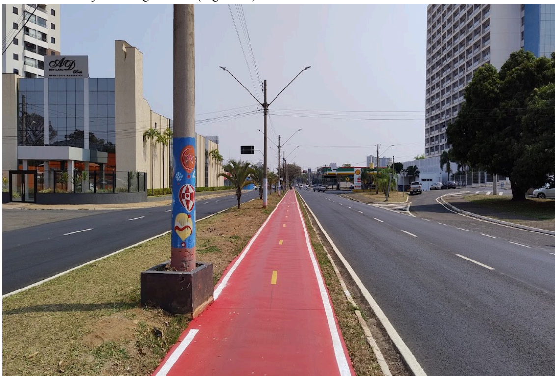
Figuras 63 e 64: Ciclovia na Avenida Visconde de Rio Claro em direção à Rodovia Washington Luiz e placa indicando “Área sujeita a alagamento” (Figura 63).
