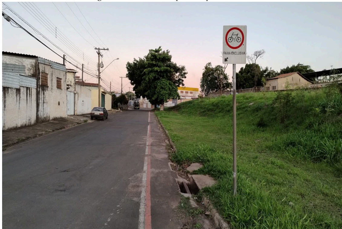
Figura 49: Ciclofaixa em péssima qualidade na Avenida 11.
