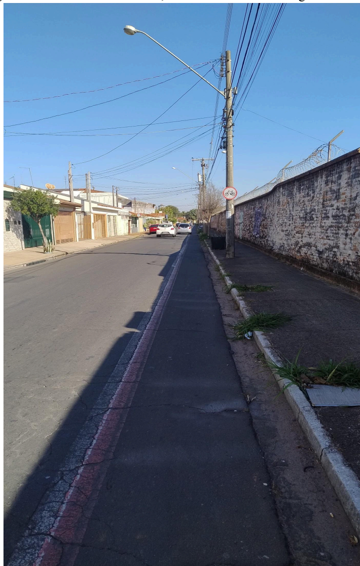
Figura 55: Ciclofaixa na Rua 3B, ao lado da Oficina de Vagões da RUMO.
