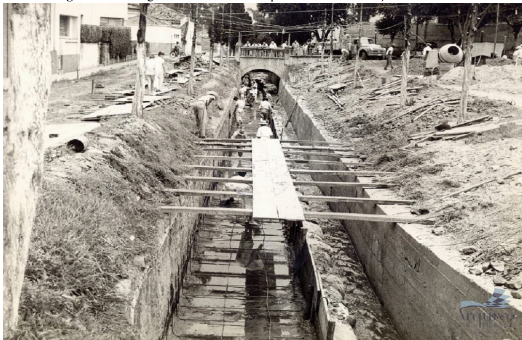
Figura 18: Córrego da Servidão em seu processo de canalização e aterramento.
