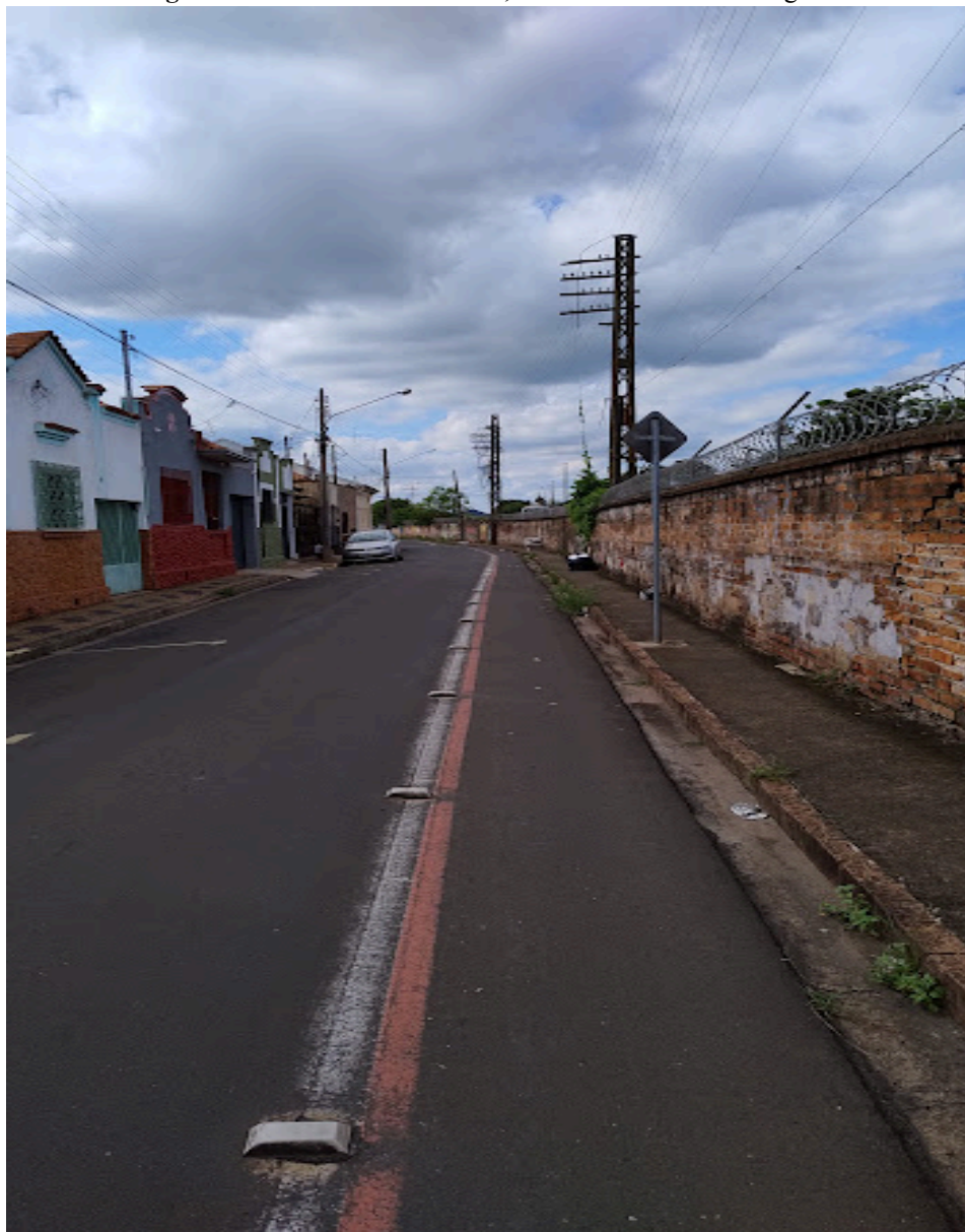
Figura 15: Ciclofaixa da Rua 1A, ao lado da Oficina de Vagões.
