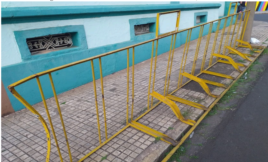
Figura 9: Paraciclo com barras de ferro retorcidas na Rua 7, Avenida 1.
