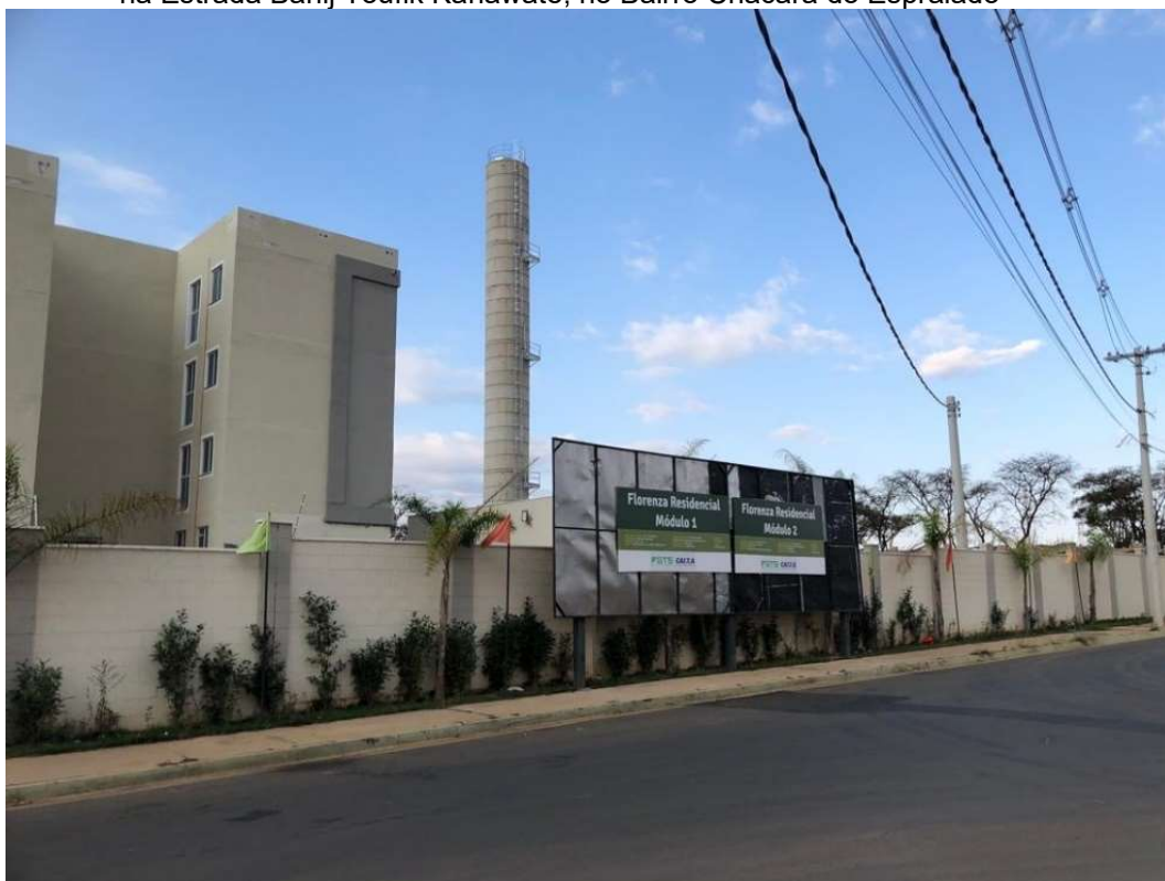
Figura 72: Condomínio residencial multifamiliar em fase de finalização de obra, localizado na Estrada Bahij Toufik Kanawate, no Bairro Chácara do Espraiado
