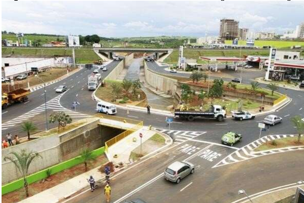
Figura 46 - Obras finalizadas no entroncamento dos córregos Cubatão e Bagres
