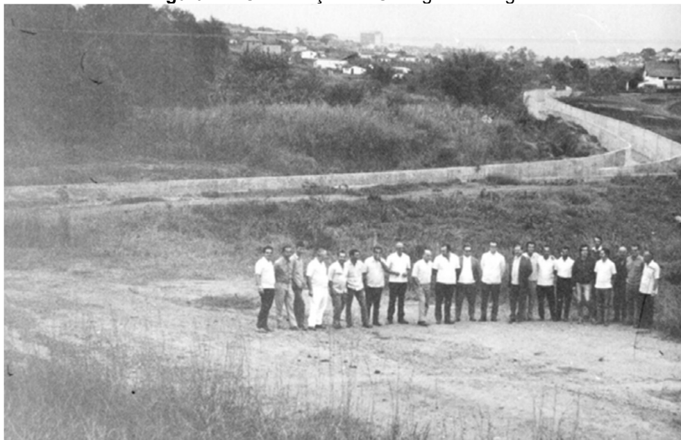
Figura 27: Canalização do Córrego dos Bagres
