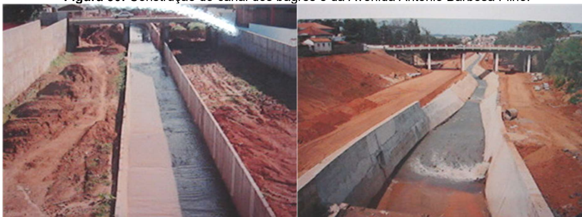
Figura 30: Construção do canal dos bagres e da Avenida Antônio Barbosa Filho.
