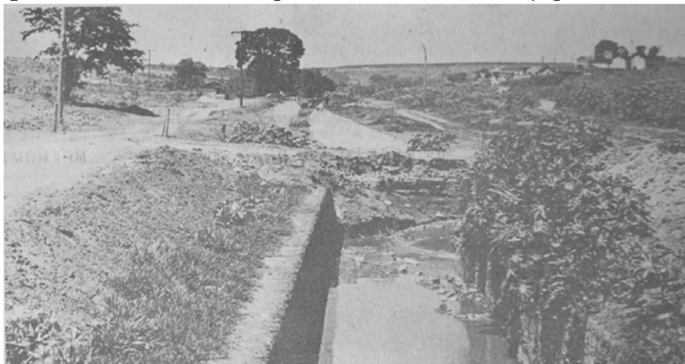
Figura 28: Saneamento do Córrego Cubatão entre as Av. Champagnat e a cachoeira
