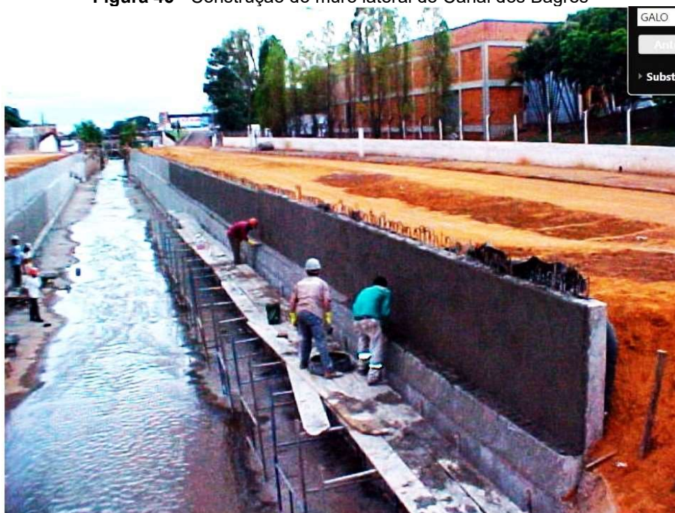
Figura 45 - Construção do muro lateral do Canal dos Bagres
