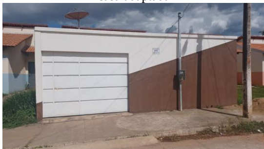
Foto 40 – Muro de alvenaria e portão de ferro – casa adaptada
