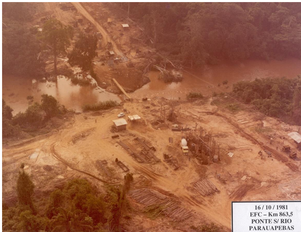
Foto 11 – Construção da ponte que liga Vila Parauapebas à Serra dos Carajás – 1981
