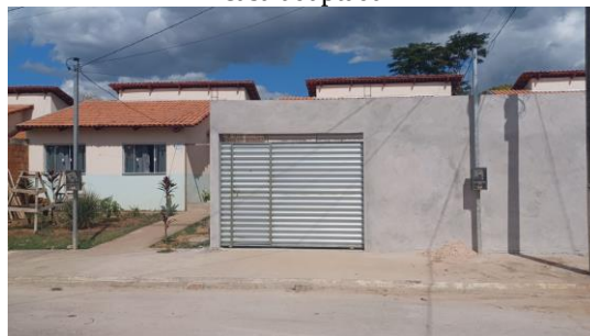
Foto 41 – Muro de alvenaria e portão de ferro – casa adaptada
