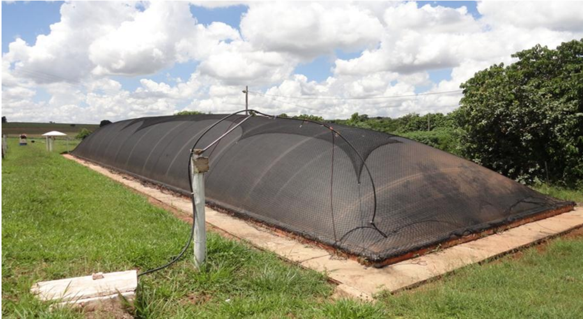
Figura 7: Vista do gasômetro com biogás
