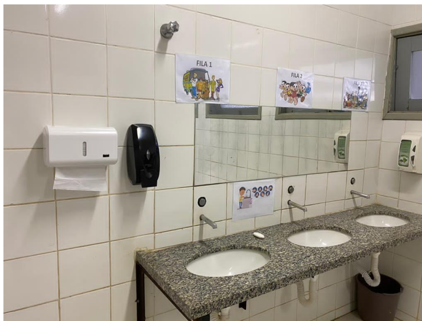
Foto 8: Banheiro dos alunos.
