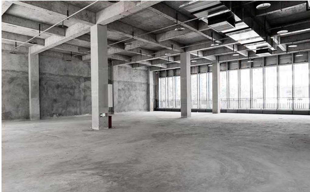
Figura 13 - Pilares em concreto armado
