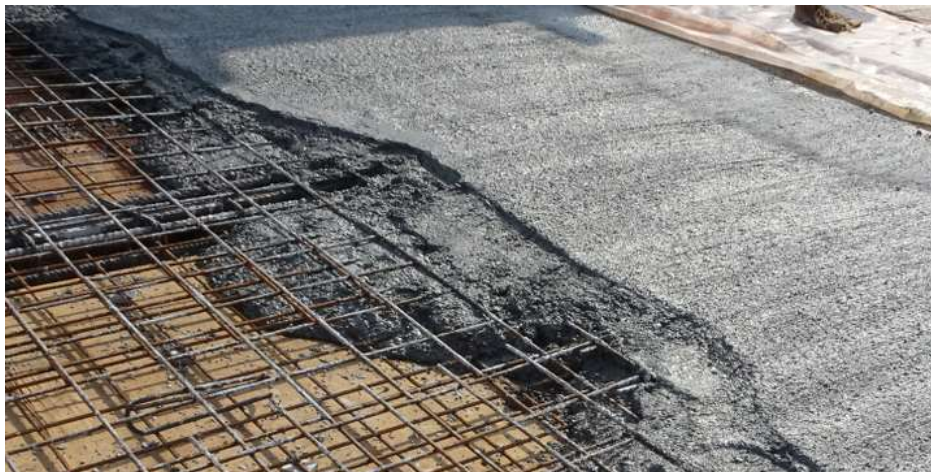
Figura 8 - Execução de laje maciça
