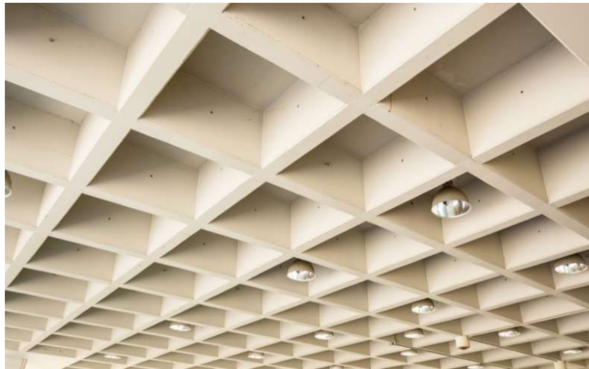
Figura 10 - Laje nervurada
