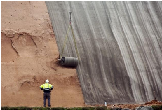
Figura 3 – Lona de concreto aplicada na proteção de taludes.
